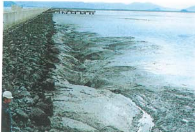
写真-2 南護岸（裏込めからの土砂の流失）
