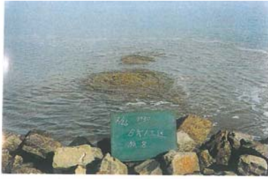
写真-1 南護岸（上げ潮時の吹き上げ）
