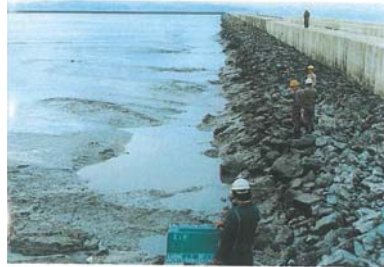
写真-5 東護岸（土砂の吸い出し穴）
