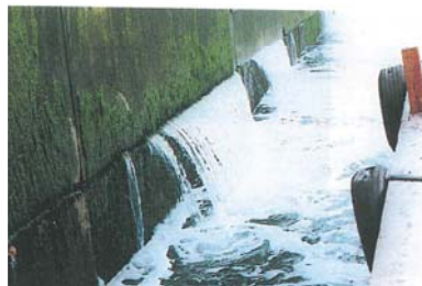
写真-5 東護岸（土砂の吸い出し穴）
