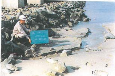
写真-2 南護岸（裏込めからの土砂の流失）
