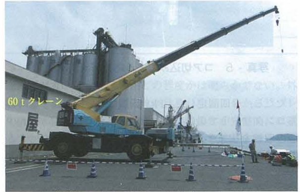
写真 - 6 荷重試験状況
