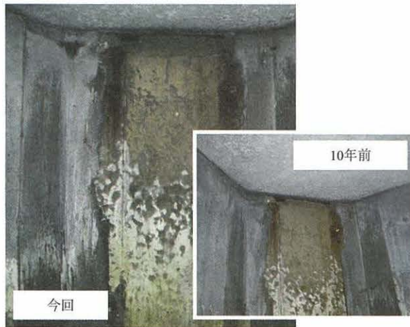
写真 - 4 杭頭部の状況
