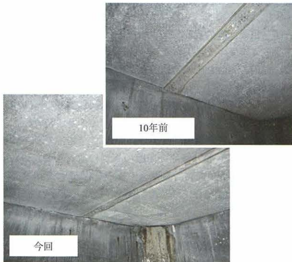
写真 - 3 CFRP 床版下面の状況
