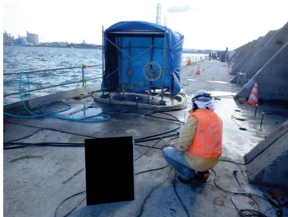
図-5.2.8 ワイヤソーイング切断状況
