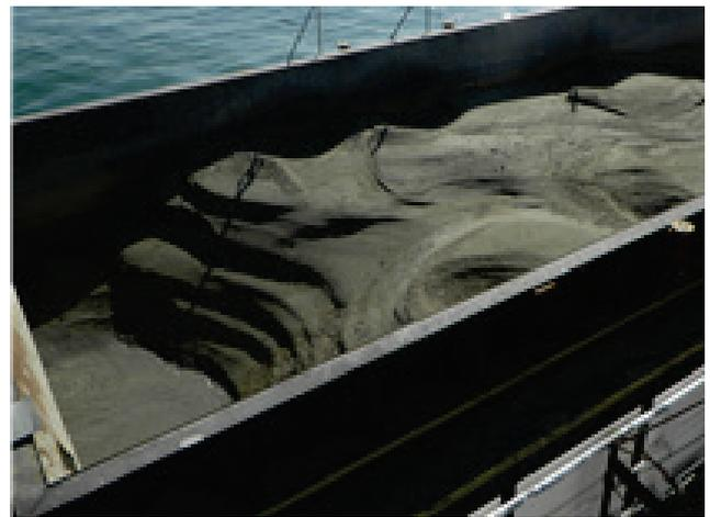
図-5.5.8 中詰砂と海水の分離状況
