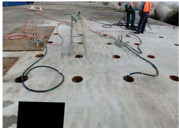
図-5.4.12 内管挿入および一次注入（CB注入）
