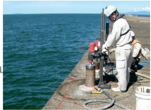
図-5.3.8 上部工削孔状況
