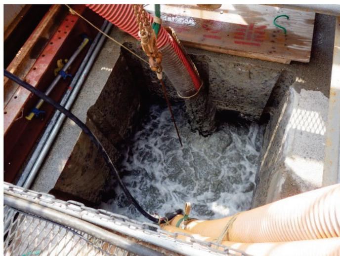
図-5.2.14 中詰材撤去状況
