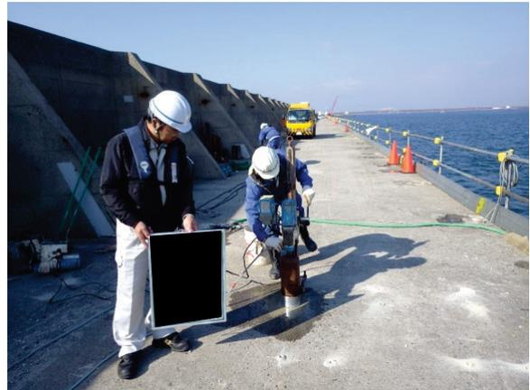
図-5.2.3 コンクリート削孔状況
