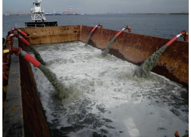
図-5.5.7 中詰材の撤去状況
