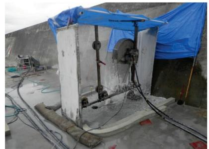
ワイヤーソーによる上部工の切断
