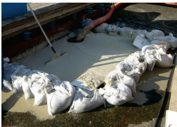
図-5.3.4 ホースを挿入して直接排泥した事例
