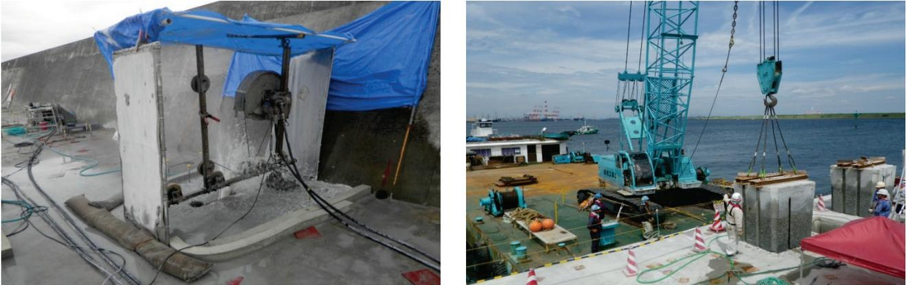
図-5.5.5 上部工切断，撤去状況
