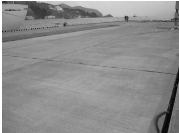
写真-6.2.2.2 エプロンの状況（異状なし）
