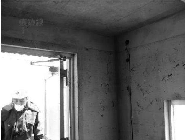
写真-2.2.2.3 八戸港の強震観測小屋 —観測小屋内部の高さ204cmにある痕跡線— (平成23年3月17日撮影)
