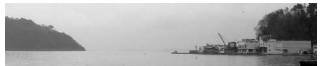
写真-5.3.4.2 写真-5.3.4.1の湾口防波堤の拡大
