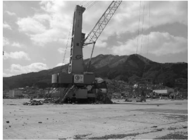
写真-6.2.3.8 ハーバークレーンの状況
