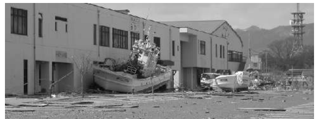
図-5.2.2.8 出崎地区の埠頭上に打ち上がった船舶
