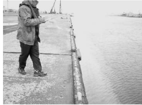
写真-6.3.14 雷神埠頭の岸壁法線 (写真番号⑦)
