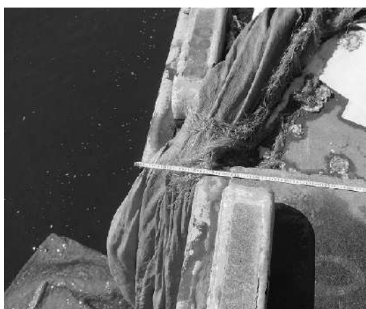
写真-6.1.1.2 写真-6.1.1.1と同一箇所の今回の状況 (平成23年3月17日撮影)
