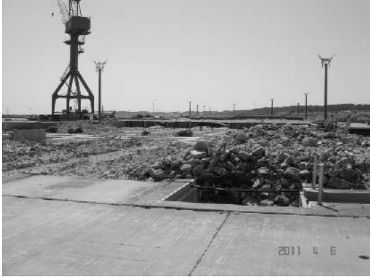
写真-5.5.3.7 常陸那珂港（ケーソンヤード）
