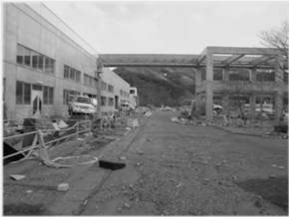
写真-5.2.3.17 建物に衝突した自動車
