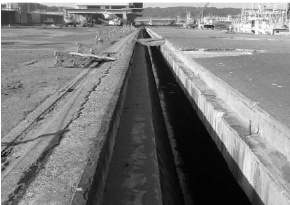
写真-6.2.1.16 諏訪下地区栈橋 (-6.0m) —津波による渡版の被害— (平成 23 年 3 月 18 日撮影)
