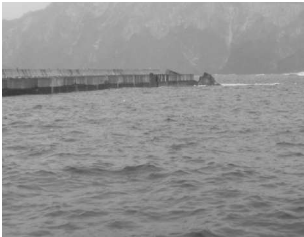
写真-6.2.2.16 南堤の状況
