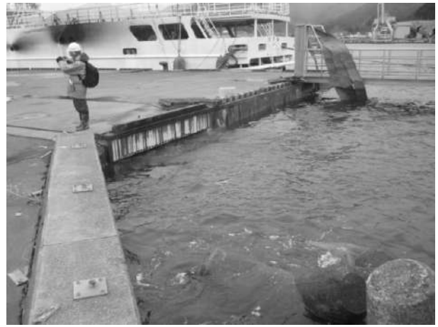
写真-6.2.2.12 栈橋端部の状況 (異常なし)
