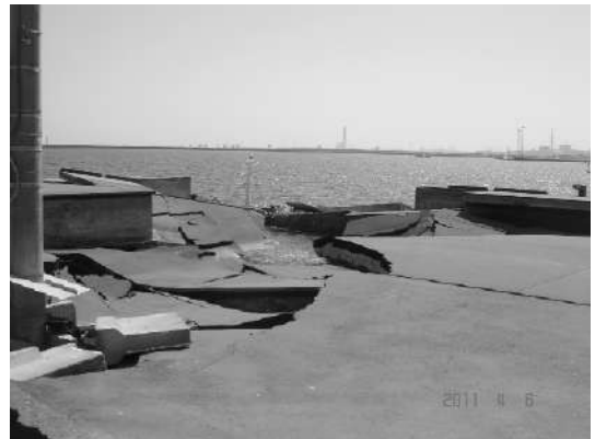
写真-5.5.2.4 日立港区第二埠頭地区(岸壁)
