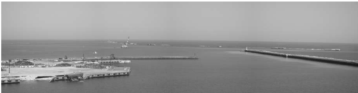
図-5.4.1.13 沖防波堤の被災状況
