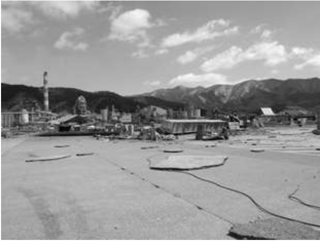
写真-5.2.4.5 防潮堤のゲートの流出 (3月18日)
