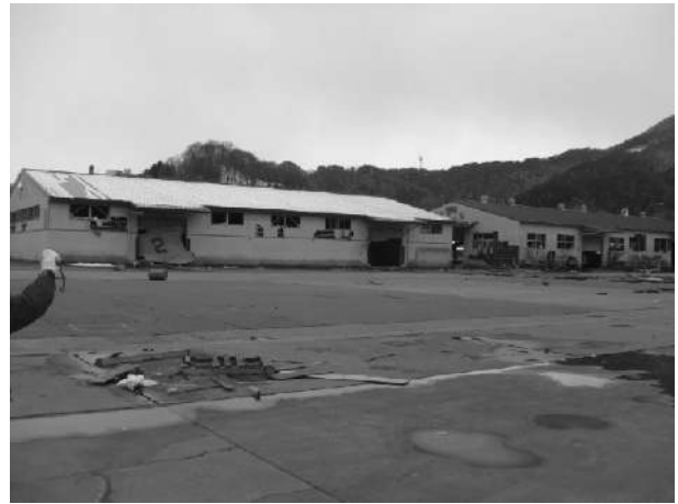
写真-6.2.2.14 県営上屋の状況
