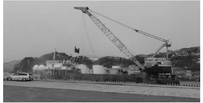
写真-5.2.3.14 航路・泊地啓開作業中の起重機船 (3月17日)
