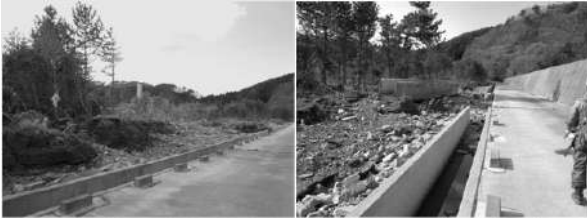
写真-5.2.3.16 東側の消波護岸背後の洗掘と倒れた松林
