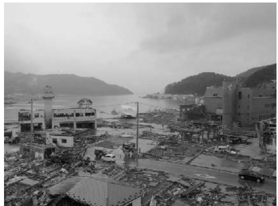
写真-5.3.4.6 女川病院から見た被害の様子② （2011年4月9日撮影）
