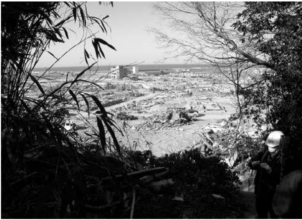
図-5.4.1.11 釣師浜漁港奥の被災状況（その1）
