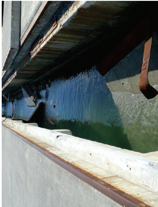
写真-6.2.1.11 諏訪下地区棧橋（-7.5m）一津波による渡版の被害一 （久慈港諏訪下地区）（平成23年3月18日撮影）
