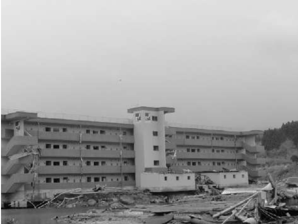
写真-5.3.3.3 4階建てのRC造の建物、避難ビルに指定されていた
