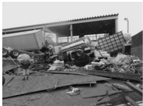
写真-5.3.7.2 雷神埠頭背後の建物 （2011年3月17日撮影）
