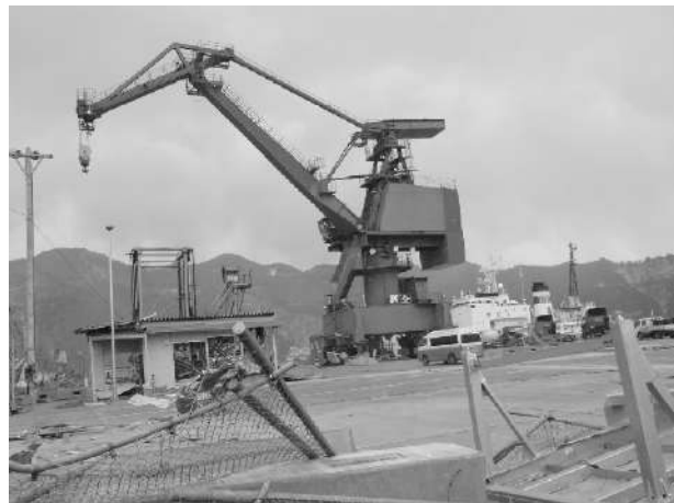
写真-6.2.2.6 ハーバークレーンの状況
