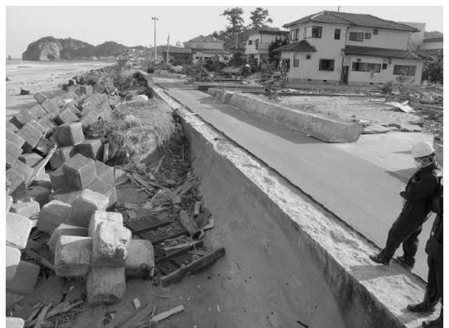
図-5.4.2.9 兎渡路における防波護岸と背後の被災状況
