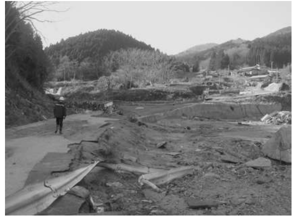
写真-5.2.4.2 綾里湾での津波の遡上（左下は海側、上は陸側）
