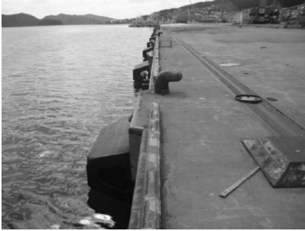
写真-6.2.3.5 栈橋法線の状況 (異常なし)
