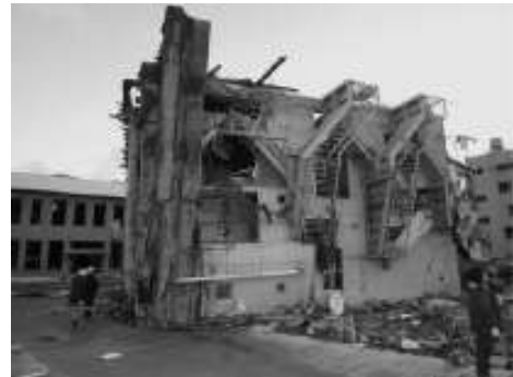
写真-6.3.29 転倒した4階建ビル（女川漁港後背地）
