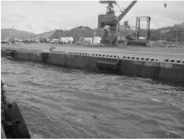
写真-6.2.2.1 岸壁前面の状況（異状なし）
