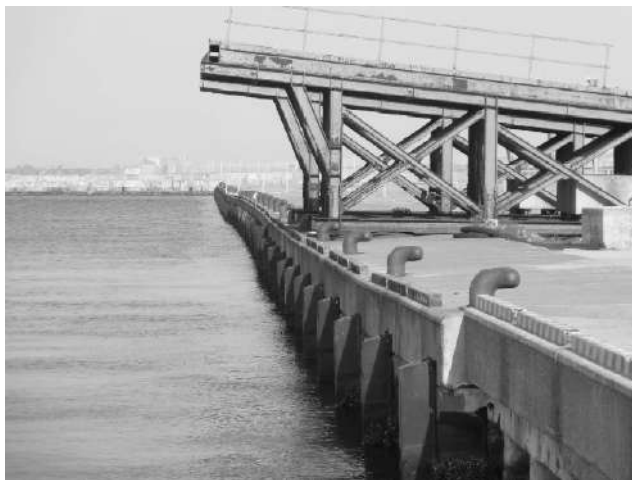
写真-6.5.2.6 南埠頭重力式岸壁(-5.5m) (2011年4月13日撮影)
