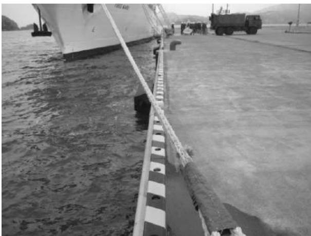
写真-6.2.2.3 岸壁法線（異状なし）
