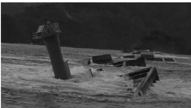
写真-7.1.3 被災後の防波堤(北堤堤頭部から)
