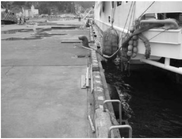
写真-6.2.2.11 岸壁法線の状況 (異常なし)
