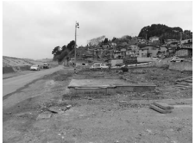
写真-5.2.5.10 防潮堤背後地域の破壊の様子
