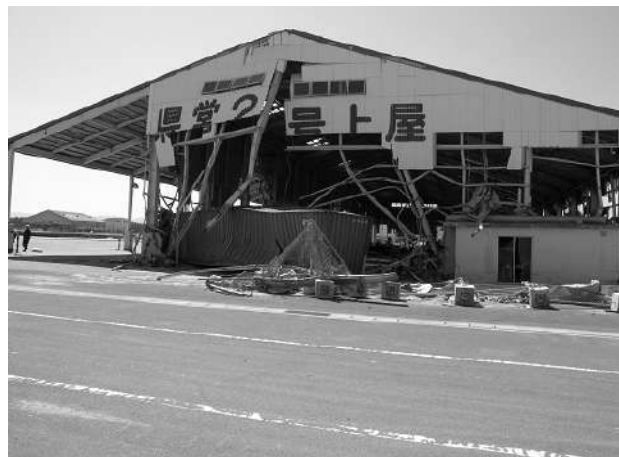
図-5.4.1.9 コンテナの衝突
