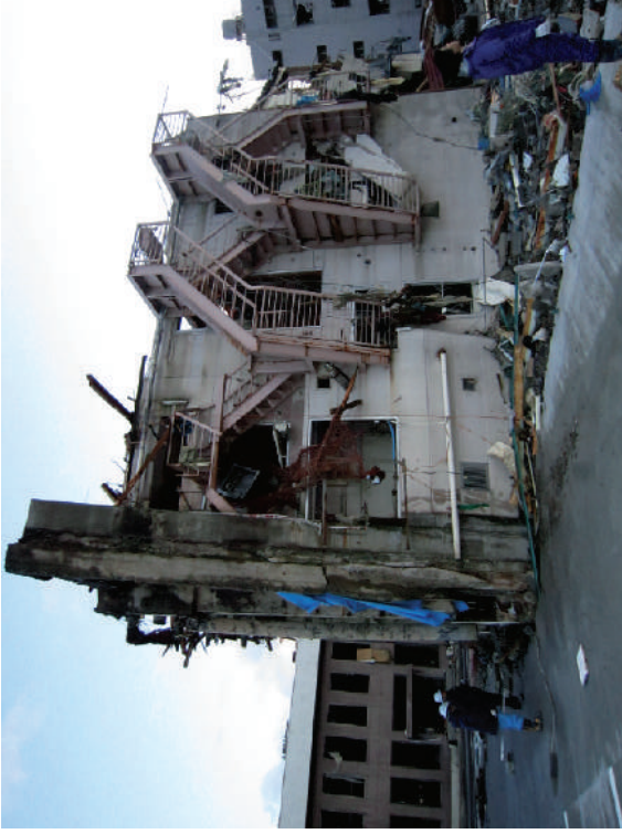
写真-6.3.29 転倒した4階建ビル(女川漁港後背地) (平成23年3月16日撮影)
