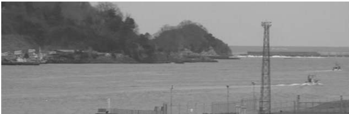
写真-7.1.1(1) 被災の進行状況(1)
