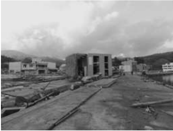
写真-5.3.4.7 岸壁近傍で倒壊した RC 造の建物 (2011年3月16日撮影)
