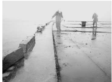
写真-6.3.7 日和埠頭南端の護岸 (写真番号⑦)
