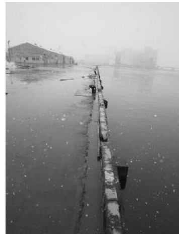
写真-6.3.1 大手埠頭の岸壁法線（写真番号①）
