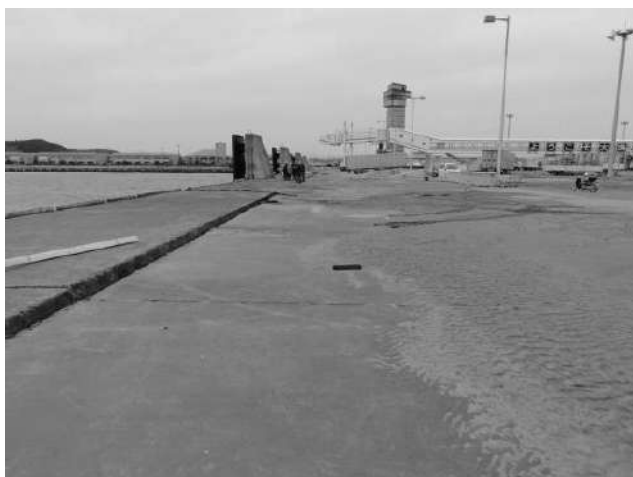
写真-6.5.3.1 第3埠頭岸壁(-8m)西側フェリーターミナル（2011年4月12日撮影）
