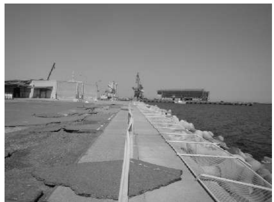
写真-5.5.2.5 日立港区第二埠頭地区(護岸フェンス)
