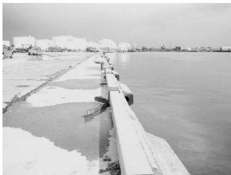
写真-6.3.8 高松埠頭の岸壁法線（写真番号①）
