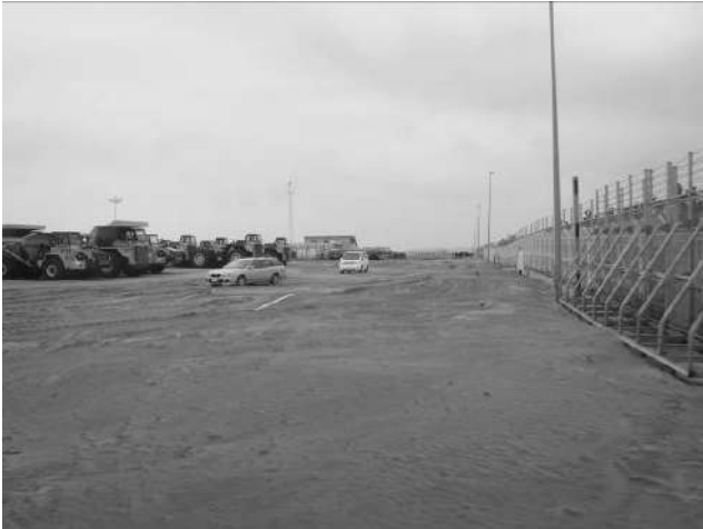
写真-6.5.2.1 北埠頭重力式岸壁(-10m)多量の噴砂 (2011年3月15日撮影)
