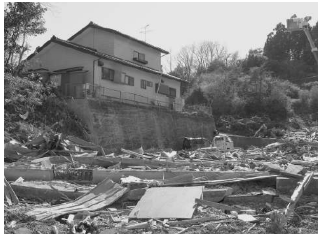
図-5.4.1.12 釣師浜漁港奥の被災状況（その2）
