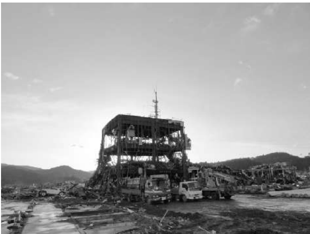
写真-5.3.3.4 町役場（フェンスの上まで水が来た）
