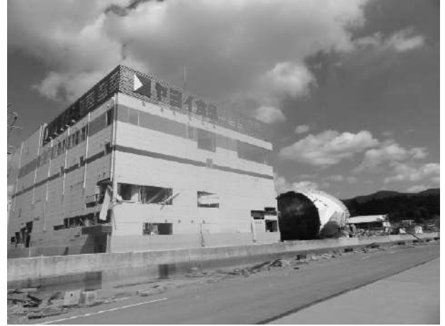
写真-5.3.2.4 気仙沼港の浜町の岸壁背後の建物と漂着した重油タンク (2011年3月28日撮影)
