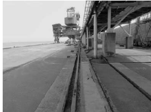
図-6.4.2.7 エプロン部・陸側レール部の状況
