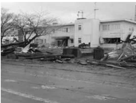
写真-5.3.5.2 大手埠頭背後の合同庁舎（2011年3月16日撮影）
