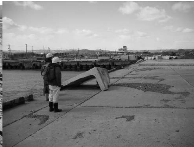
写真-6.2.1.8 諏訪下地区岸壁 (-10m) —大型の漂流物の一例— (平成23年3月18日撮影)
