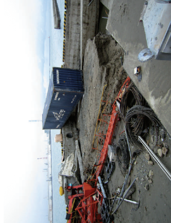
写真-6.2.1.11 諏訪下地区棧橋（-7.5m）一津波による渡版の被害一 （久慈港諏訪下地区）（平成23年3月18日撮影）
