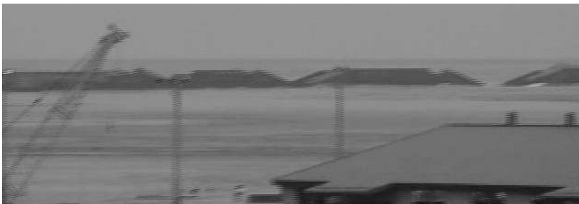
写真-7.1.1(3) 被災の進行状況(3)
