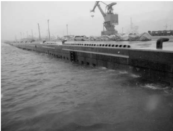
写真-6.2.2.7 岸壁前面の状況（異状なし）
