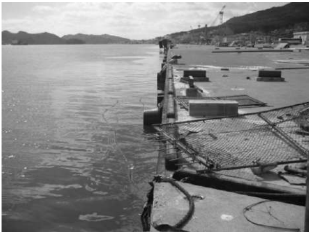
写真-6.2.3.1 栈橋法線の状況 (異状なし)
