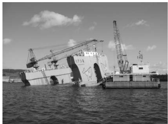
図-5.2.1.15 諏訪下地区におけるFDの被災
