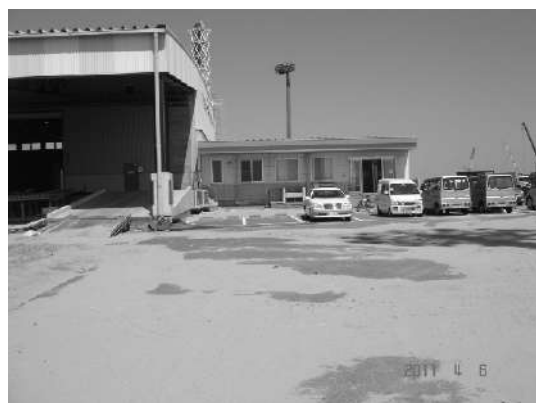
写真-5.5.3.1 ひたちなかFAZ物流サイト
