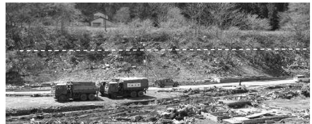
図-5.2.3.8 両石の中ほどから奥にかけて残る津波漂流物の筋
