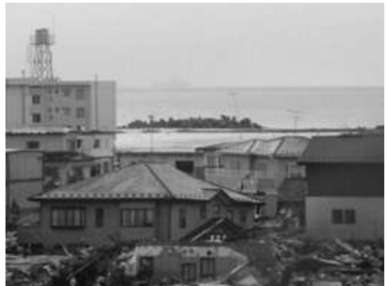
写真-5.3.5.4 離岸堤（2011年3月16日撮影）
