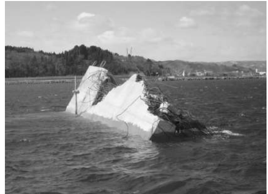
図-5.2.1.14 諏訪下地区の仮置きケーソンの被災
