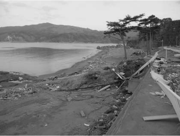
図-5.2.2.16 高浜地区における海岸の状況
