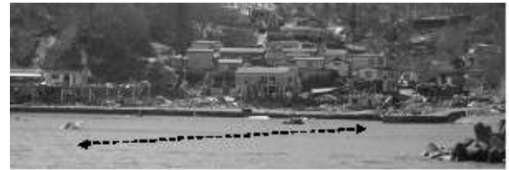
図-5.2.1.13 玉の脇防波堤の被災状況
