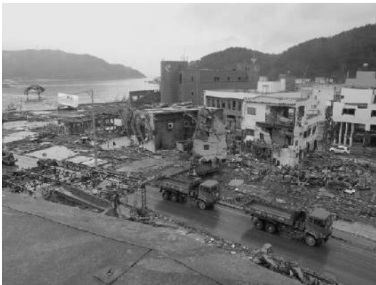
写真-5.3.4.8 女川病院から見た被害の様子③(1) (2011年4月9日撮影)
