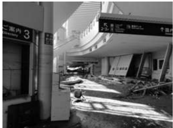
写真-5.3.8.1 ターミナル内部の様子（2011年3月18日撮影）
