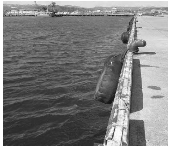
写真-6.2.1.2 諏訪下地区岸壁 (-10m) の法線の状況 (平成23年3月18日撮影)
