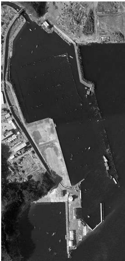
図-5.2.2.11 藤原・神林地区マリーナの被災防波堤 (下：国土地理院提供写真の一部)
