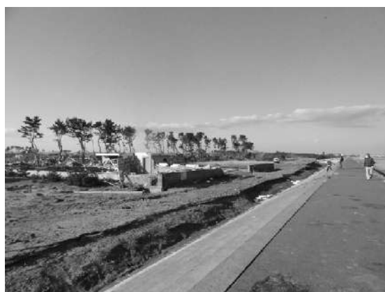
写真-5.3.8.12 護岸背後の砂丘と松林 (2011年3月18日撮影)
