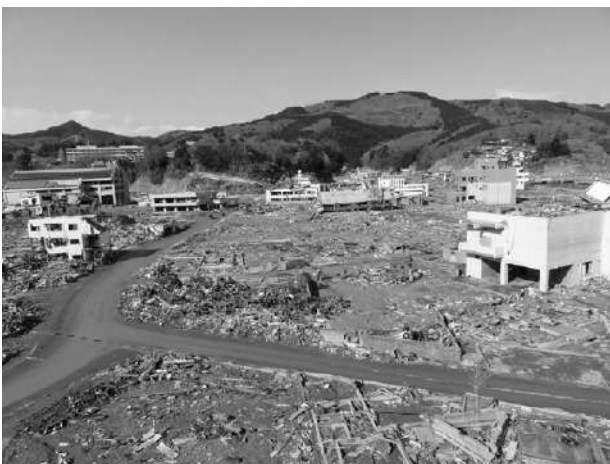
写真-5.3.4.4 女川病院から見た被害の様子① （2011年4月9日に撮影）
