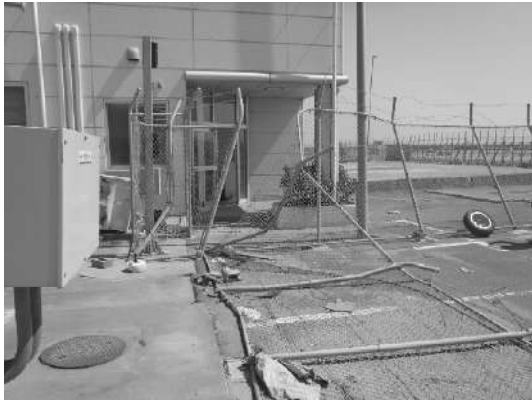
写真-5.5.2.2 日立埠頭コンテナターミナル事務所
