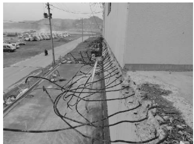
写真-5.2.5.7 下水処理場の2階テラス部
