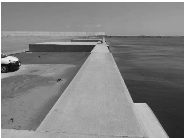
写真-6.5.4.1 外港地区岸壁(-14m), 整備中 (2011年4月12日撮影)
