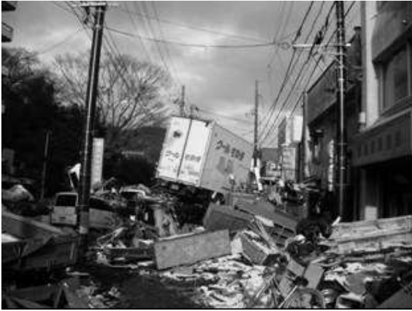
写真-5.2.3.11 道路を埋める瓦礫と車 (3月17日)
