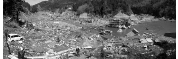
写真-5.2.3.19 両石地区の被災状況
