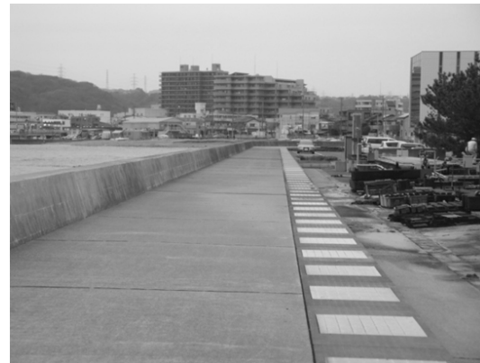
(b) 護岸背後の排水溝
