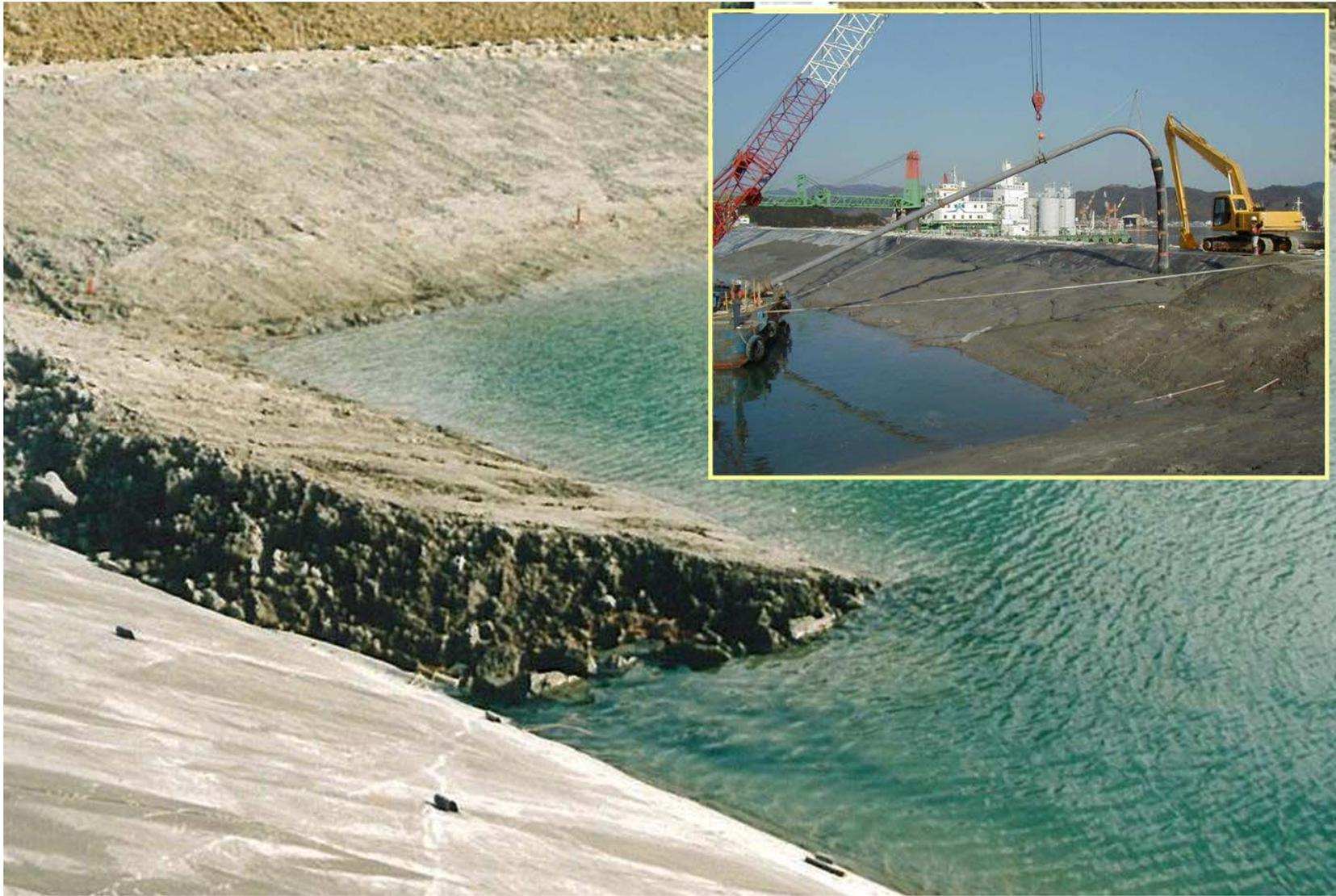
1枚目の遮水シート表面に保護層として打設された貧配合セメント処理土
