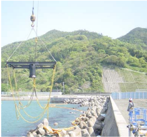
写真-3 作業開始 (0 秒)
