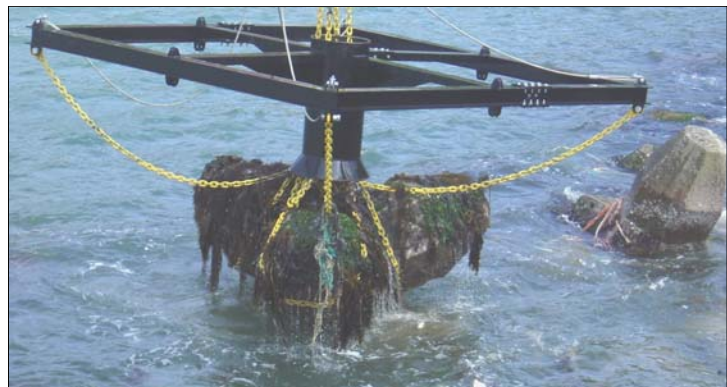
写真5 既設消波ブロック撤去工事
