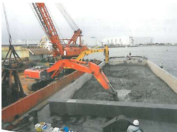
図-7.1 製鋼スラグ混合土の攪拌状況、供試体の外観及び観察位置
