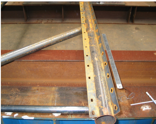
写真-7 アーチ鋼板取付けプレート
