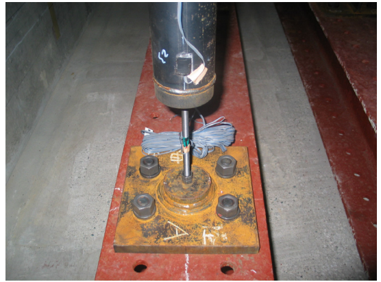
写真-8 陸側杭(引抜き側)下端バネ部材
