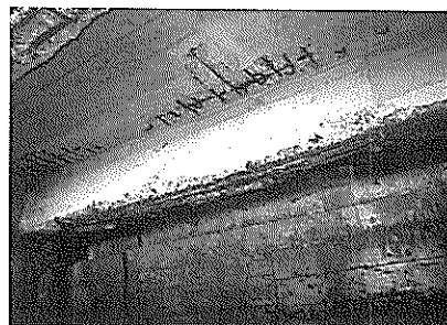
(b) 鉄筋断面減少が少ない (床版, はく落約 20%)
