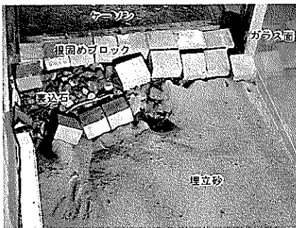
写真-3.14 越波水による護岸天端の破壊と埋立砂の吸い出し (防砂シート無しの場合)
