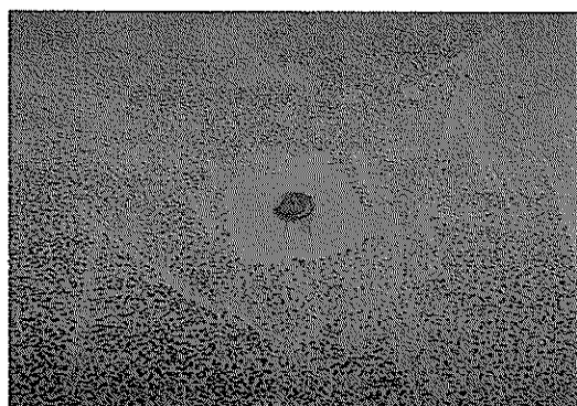
写真一五 セメントミルク硬化後の舗装表面
