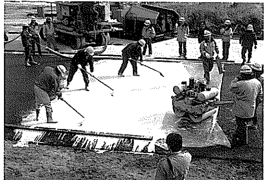
写真-4 セメントミルクの注入状況
