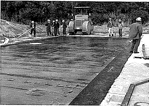
写真-1 タックコートの散布状況
