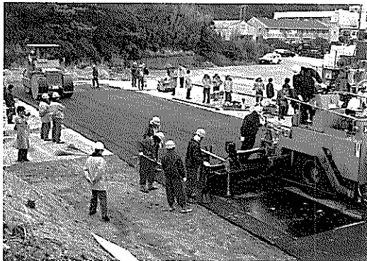
写真-2 アスファルト混合物の敷き均し状況
