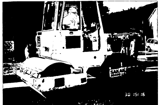
写真-6 垂直振動ローラーによる転圧2次転圧に、通常の振動ローラーよりも締固め能力の高い垂直振動ローラーを用い転圧を行った。
