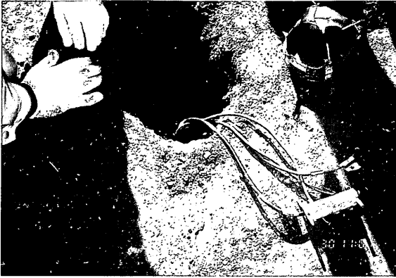
写真-9 ひずみ計および熱電対の設置状況
