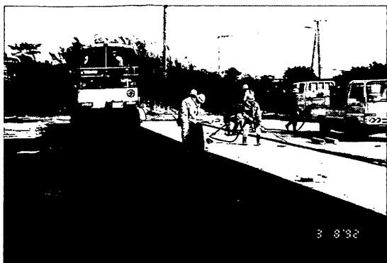
写真-5 ローラー転圧状況
