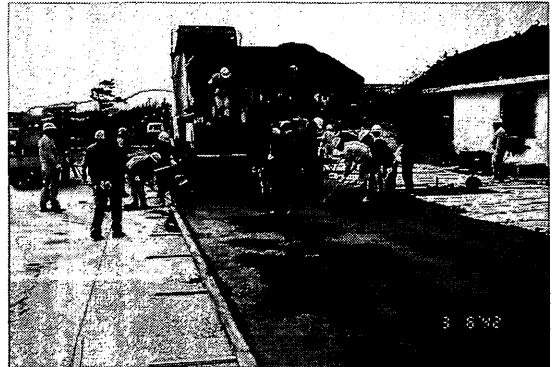
写真-4 フィニッシャーによる敷均し
