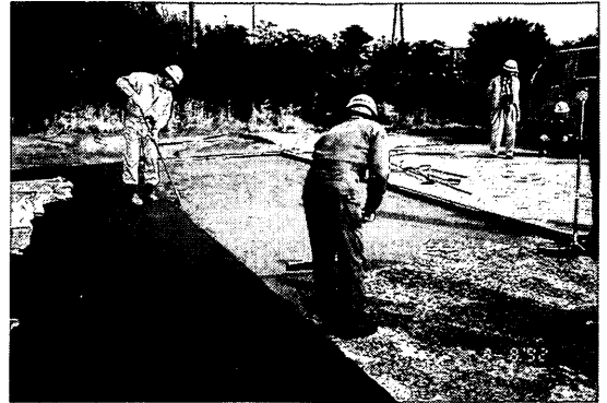
写真-3 接着剤塗布状況
