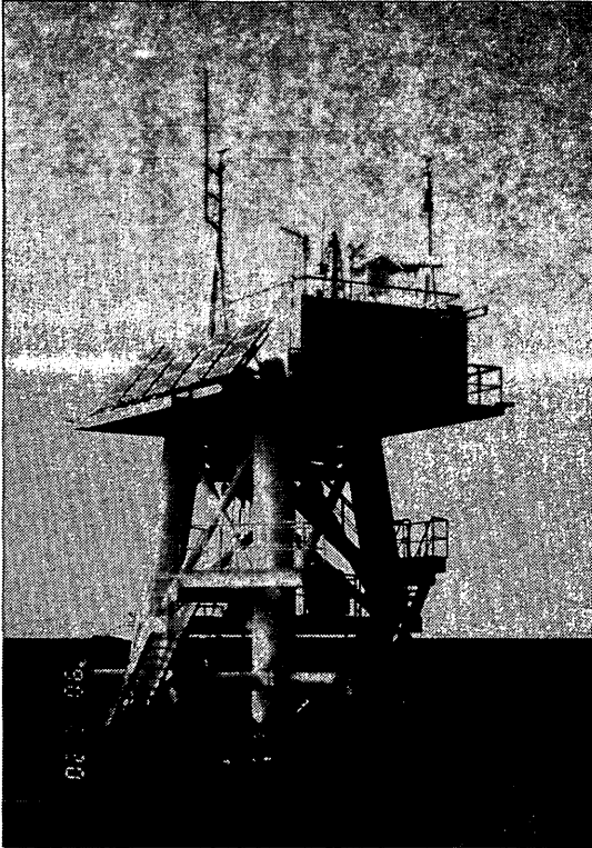
写真 3.1 大阪湾海上観測塔
