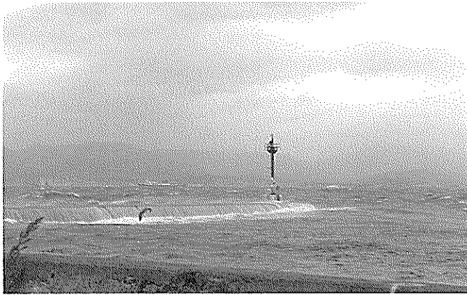
写真一 2(b) 函館港防波堤の越波状況 (天端の低い防波堤)
