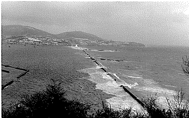
写真一 3(c) 小樽港防波堤の越波状況（越波状況の全景）
