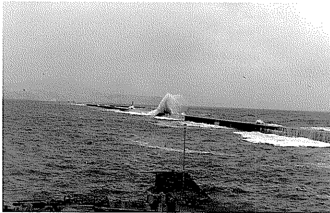
写真一 3(b) 小樽港防波堤の越波状況（打ち上がった越波水が落下している状況）
