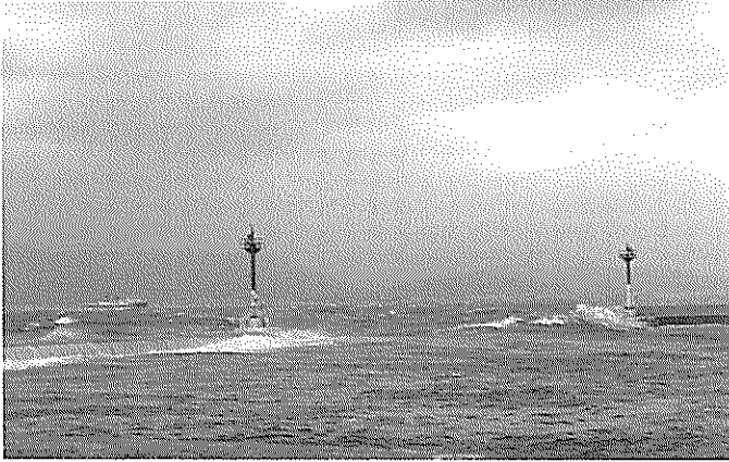
写真一 2(a) 函館港防波堤の越波状況 (天端高さの異なる二つの防波堤)
