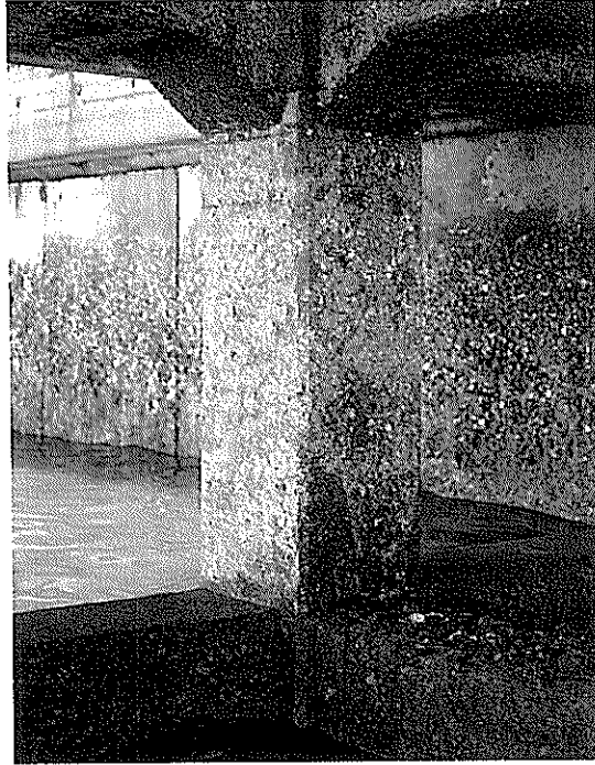
通電前の干満帯柱部の外観
