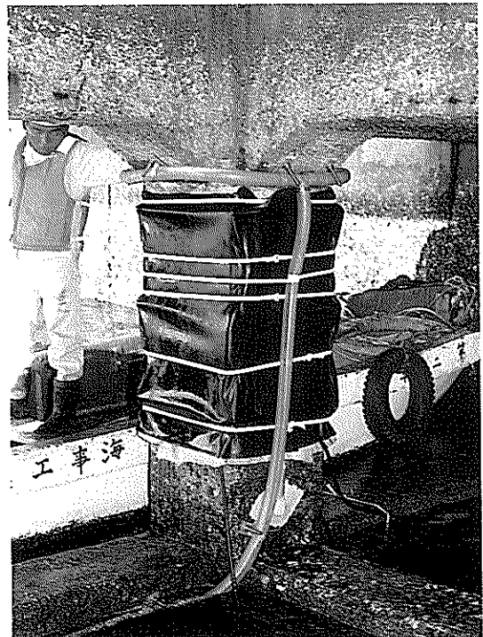
外装用ラバー、海水注水パイプ取付け状況
