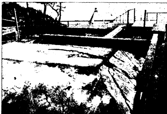
写真-9 最終加振後の盛土の破壊状況 (ケース2)
