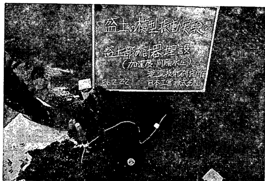
写真-3 計測器の埋設
