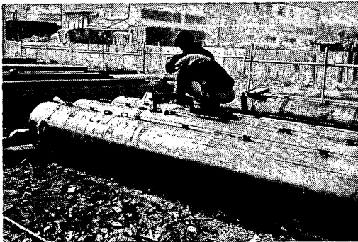
写真-2.3.1 杭体ひずみ計の取付
