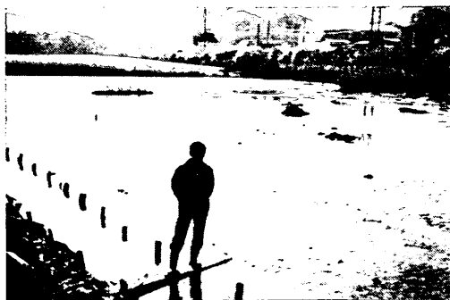
写真-2.1.1 盛土前の現地盤
