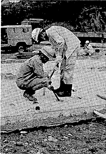
写真-5.3 ホーンからの鉄筋およびグラウトの抜き取り
