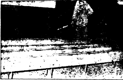
写真-3 サンドブラストによる1種ケレン
