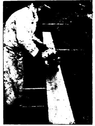
写真-4 動力工具による2種ケレン
