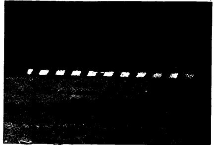
写真-7 スコッチライトの反射状況（施工直後，夜間）
