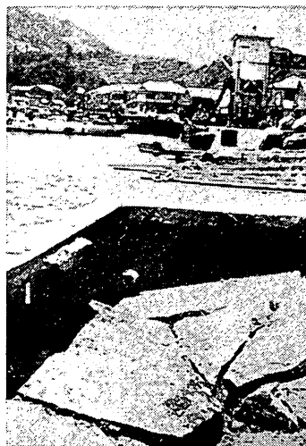
写真-5.22 腐食傾向(a)の発生と超波による上部工の陥没状況
