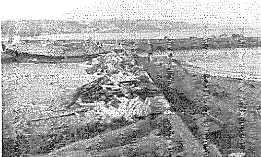
写真—1.122 地頭方漁港の突堤を南側より見る
