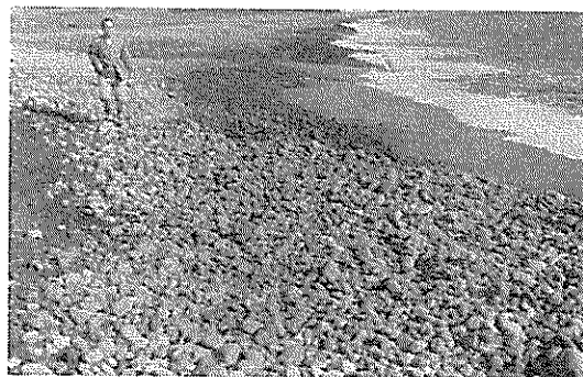
写真一.1.101 大井川港放水路北側海岸
