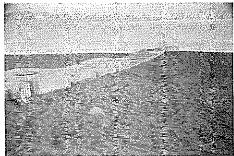
写真一.1.5 田子浦東側砂防突堤先端部
