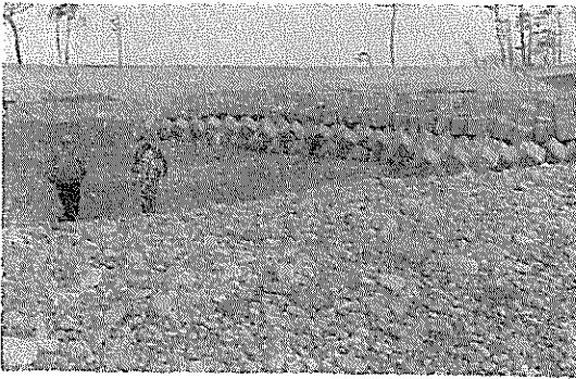
写真一.55 富士海岸五軒屋前面の六脚突堤その1 突堤前面の砂利の推積に注意
