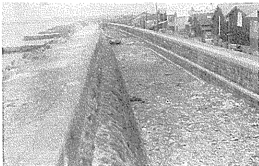
写真—1.92 焼津港鰯ヶ浜海岸堤防と副堤
