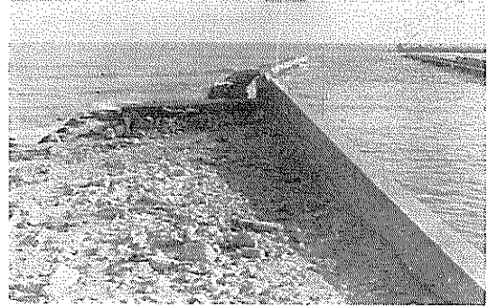
写真—1.117 相良港導流堤，北側の砂の堆積に注意離岸堤状のものが短いが導流堤から直角に出ている
