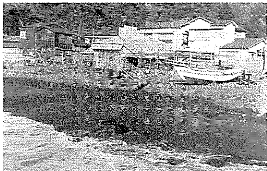
写真一.25 土肥港大藪地区泊地内海岸
