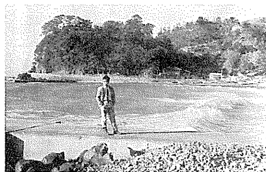
写真一.24 土肥港大藪地区防波堤
