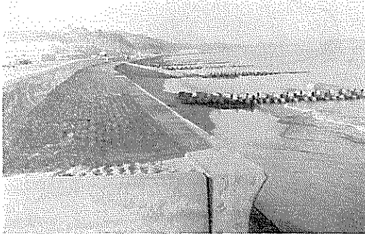
写真—1.120 地頭方漁港北側海岸(その1)北方を見る
