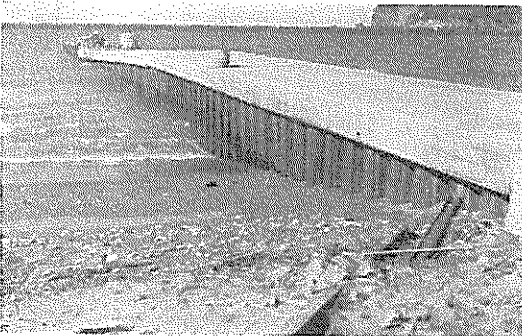
写真-1.19 宇久須港防砂堤
