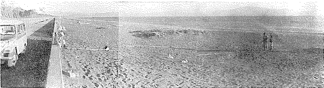
写真一.45 植田附近(断面測点 e 点) 砂面より防波堤は 1 m ほど出ている
