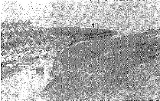
写真-1.78 大谷川河口の閉塞
