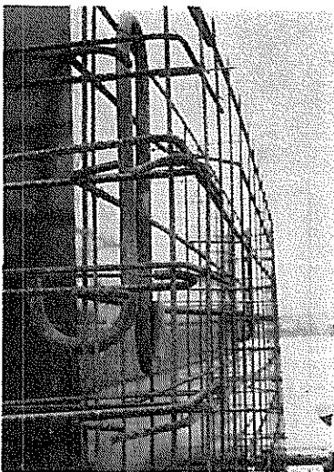
写真-2.6 ケーソン隅角部の定着 (H港工事事務所)
