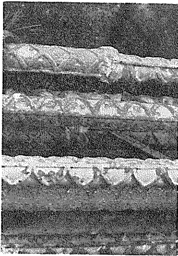
写真—2.1 ガス圧接継手 (1) (○港工事事務所)
