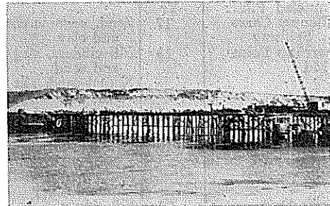
図—2.96 23年経過した鋼杭棧橋の取りこわし状況 (Santa Barbara, California)
