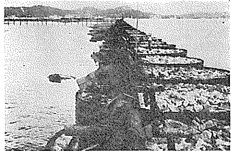
図-2.65 コルゲート・セルの中詰め
