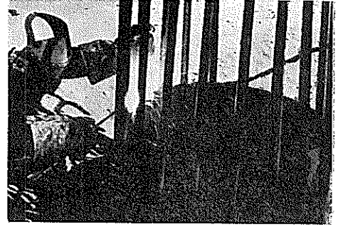
図-2.28 鋼管杭の頭部加工（1）
