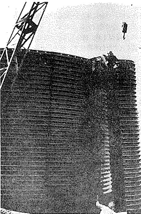
図-2.63 コルゲート・セルの組立て
