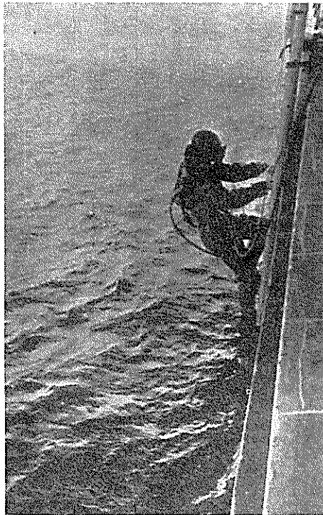
図一2.98 デンマークの港湾で使用している鋼矢板岸壁の現有厚み測定状況
