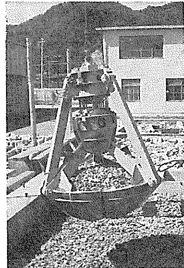
写真—2 オレンジピールによる砂利のつかみ状況、フラッシュ容量 0.05m^3 W_g=160Kg
