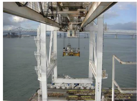
写真-2.5 ブーム陸側後端からの海側の状況 (KOCKS 社製クレーン, X424, 休止時)
