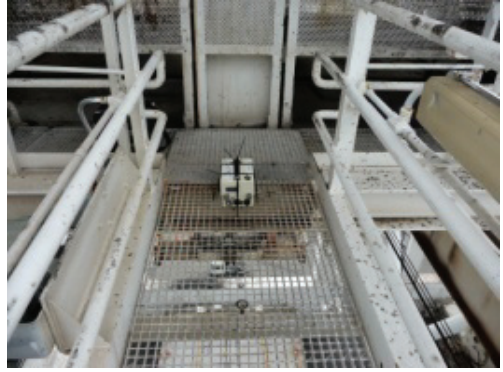
写真-2.9 震動計のブーム上への設置状況
