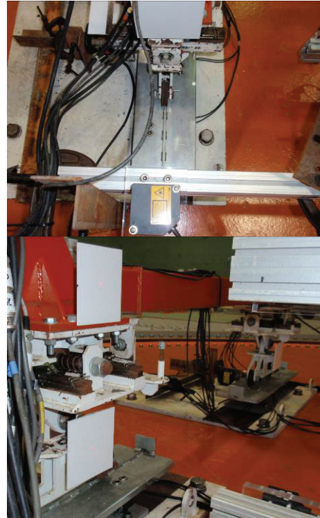
写真-3.4 レーザー変位計による免震装置上下での変位計測
