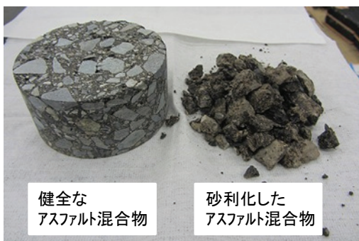
写真-1 アスファルト混合物の砂利化
