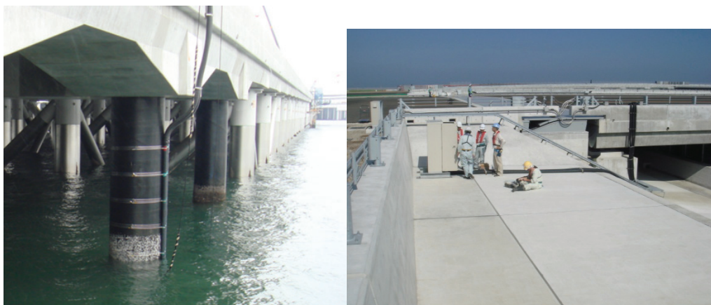
写真-1 調査杭の外観 (左：調査杭，右：測定ボックス)
