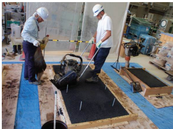
b) アスファルト混合物の転圧時
