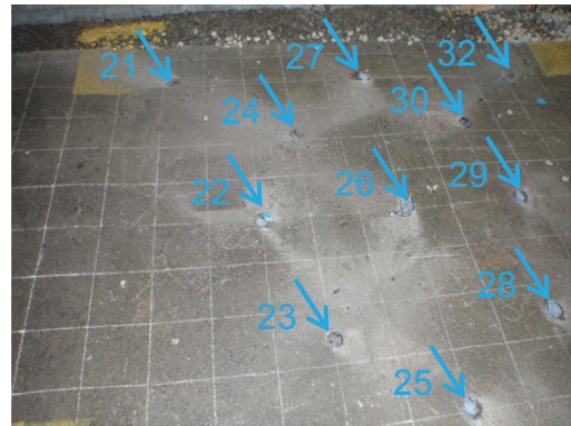
a) 削孔後のシリコン注入状況 (番号は図-3.16 に対応)
