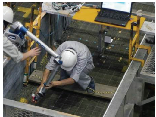
写真-3.4 レーザースキャナーによる計測状況
