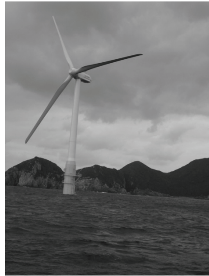
写真-3.3 長崎県杵島沖 2MW 洋上風車 (2013.11.25.)
