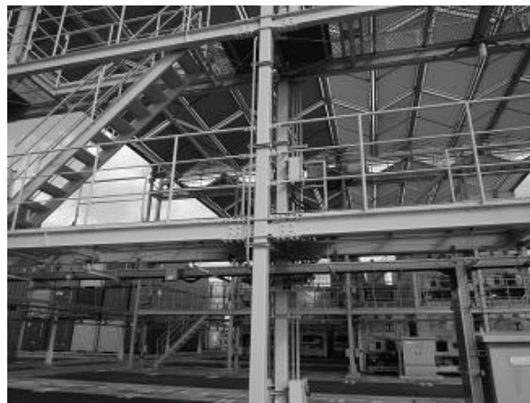
写真-2.4 リーファー設備での開閉式の屋根
