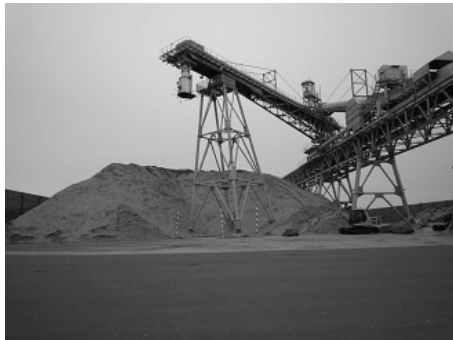
写真-A.2 チップヤードと荷役用ベルトコンベア
