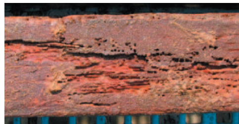
写真-12 海水浸漬8年後の低分子フェノール樹脂処理試験体の側面
