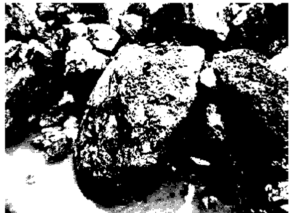
写真-5.5 上層の捨石（フジツボ等の付着物の境界が明瞭に観察された）
