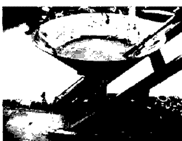
注人状況・注人時の観測孔の様子 (間隙水が薬液の注人に伴い流出している)
