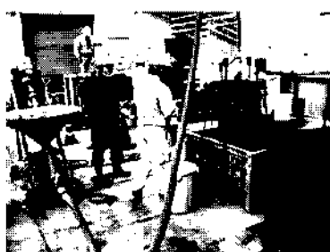
注人状況・注人時の観測孔の様子 (間隙水が薬液の注人に伴い流出している)
