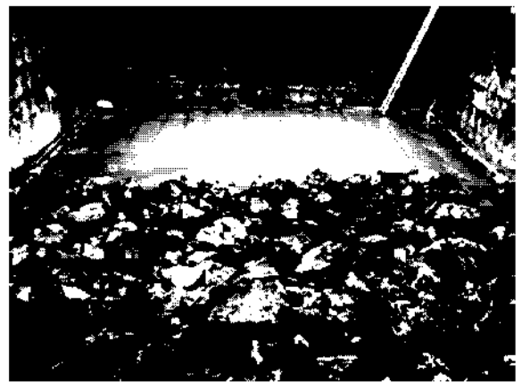
(d) 船倉内捨石全景 (手前側：上層の捨石，奥側：中層の捨石)
