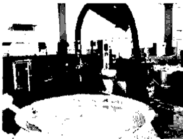
注入状況～充填完了（視測孔や視測孔周辺のモルタル蓋からモルタルが流出）
