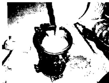
注入状況～充填完了（視測孔や視測孔周辺のモルタル蓋からモルタルが流出）
