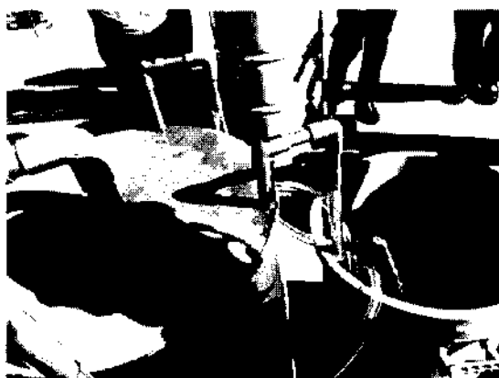
(c) 水抜きパイプ排出状況
