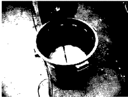
懸濁型薬液練混ぜ及び投入
