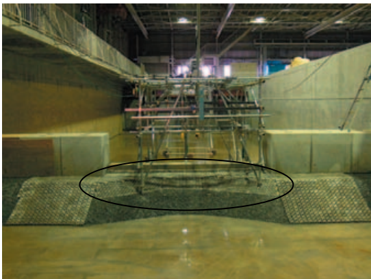
(a) 被覆ブロックの設置の様子
