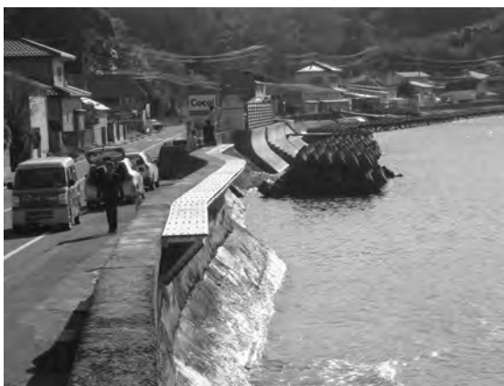
写真-4.1 直立護岸に後付けされた簡易波返し工(石巻市大原海岸での設置状況(2009年12月撮影))
