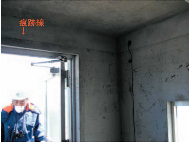
図-27 八戸港の強震観測小屋 一観測小屋内部の高さ 204cm にある痕跡線— (平成 23 年 3 月 17 日撮影)
