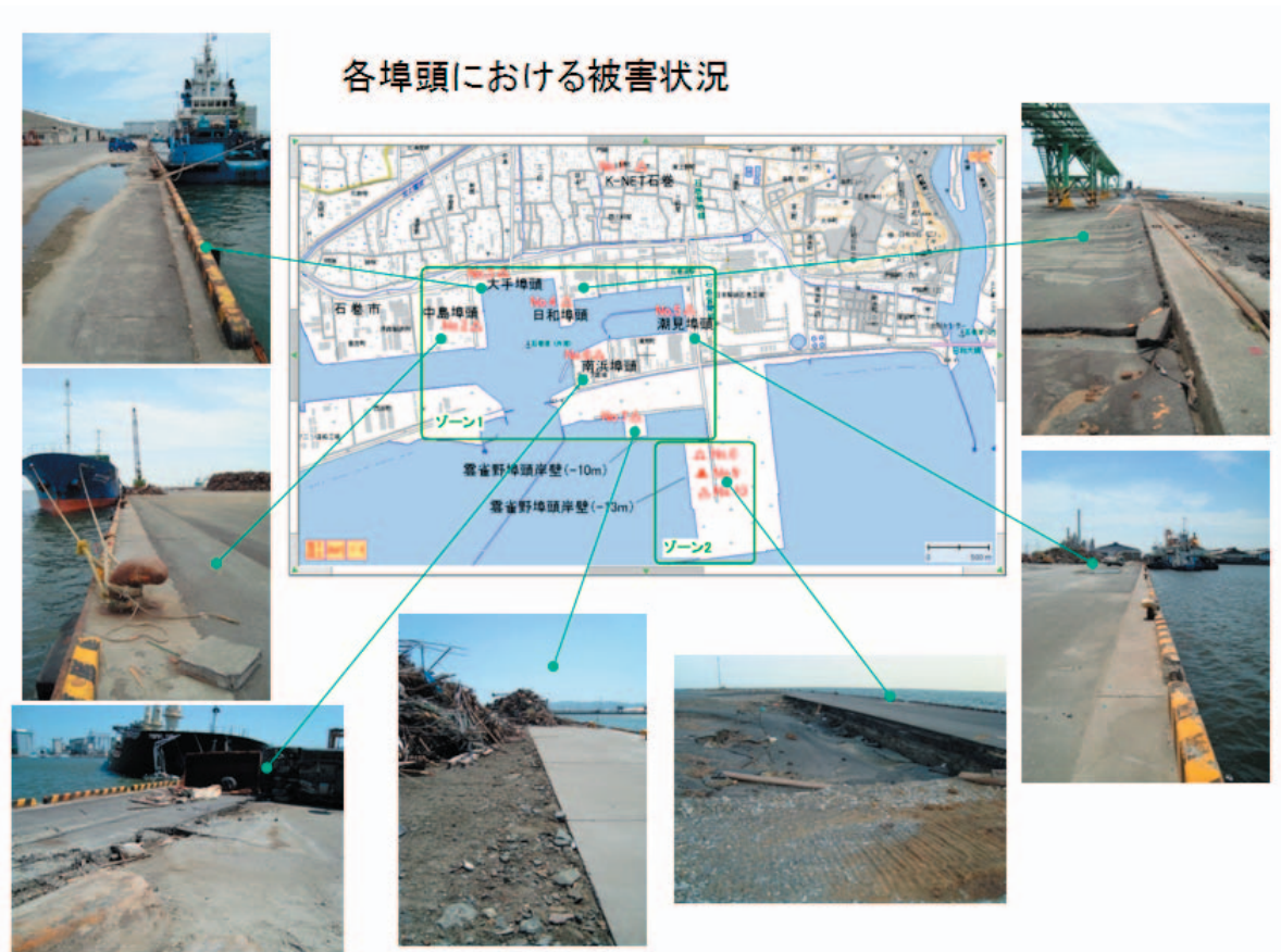
図-5.3 石巻港の各埠頭における被害状況
