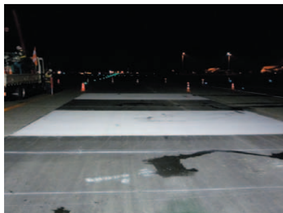
写真-6 塗布完了時
