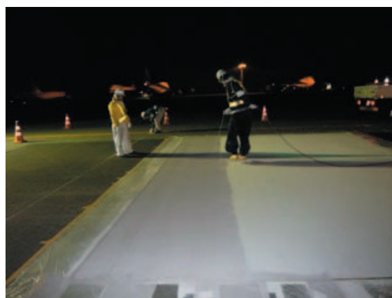
写真-5 遮熱材の塗布(2層目)
