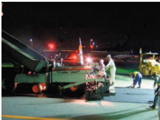
写真-1 短時間での夜間施工を強いられる空港
