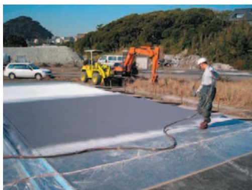
写真-4 試験施工状況
