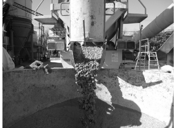
写真-4.2 ホッパへの投入状況
