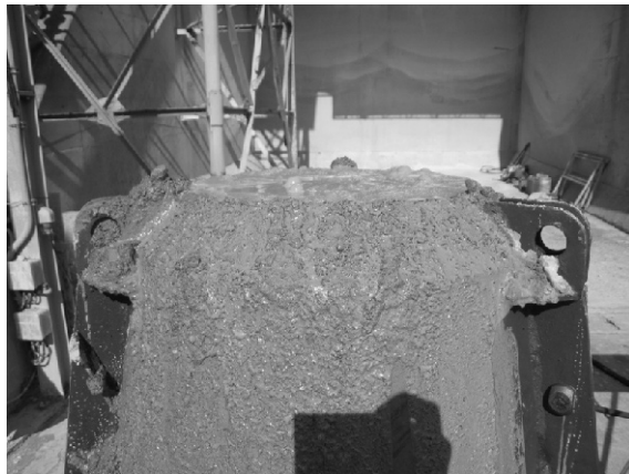
写真-4.4 打設終了後の試験体上面 (65-70)
