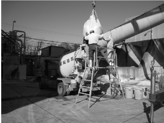
写真-4.1 アジテータ車による練混ぜ状況
