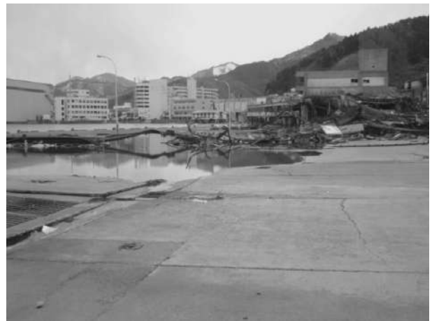
写真-6.2.2.21 エプロンの湛水状況
