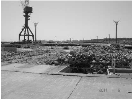
写真-5.5.3.7 常陸那珂港（ケーソンヤード）
