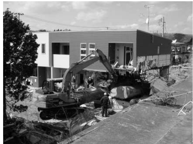
図-5.2.2.13 原木が衝突した建物
