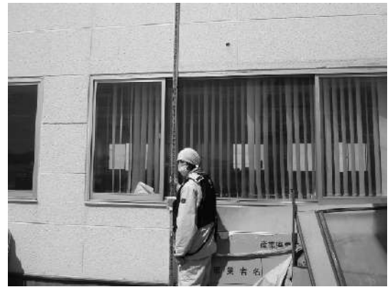
写真-5.5.5.3 鹿島港（南公共埠頭）
