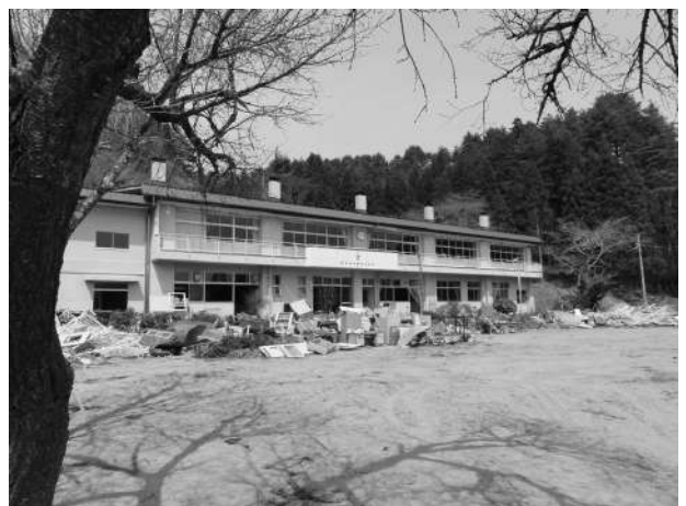
写真-5.2.5.5 鵜磯地区での小学校の痕跡 （標高おおよそ23m）
