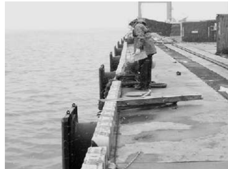
写真-6.3.15 高砂埠頭 2号岸壁の岸壁法線 (写真番号⑧)
