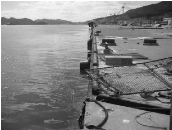
写真-6.2.3.1 栈橋法線の状況 (異状なし)
