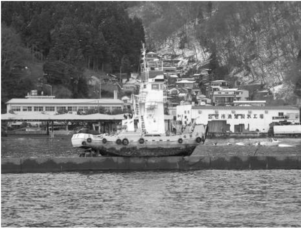
写真-5.2.3.4 波除堤に上がった小型船舶 (3月17日)
