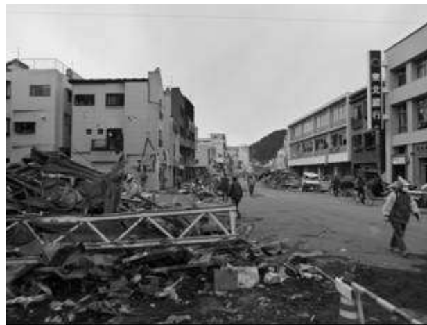
写真-5.2.3.9 1階から2階まで浸水した市街地 (3月17日)
