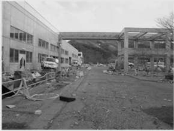
写真-5.2.3.17 建物に衝突した自動車
