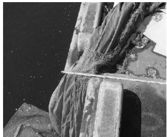
写真-6.1.1.2 写真-6.1.1.1と同一箇所の今回の状況 (平成23年3月17日撮影)
