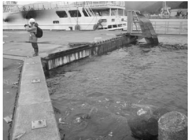
写真-6.2.2.12 栈橋端部の状況 (異常なし)
