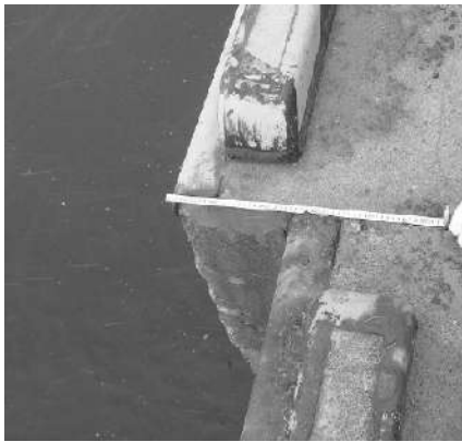
写真-6.1.1.9 写真-6.1.1.8 と同一箇所の今回の状況 (平成 23 年 3 月 17 日撮影)
