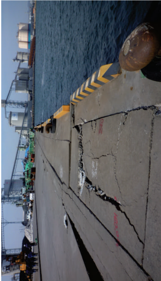
図-6. 4. 2. 4 構造変化位置での法線の出入り (小名浜港 4 号埠頭)
