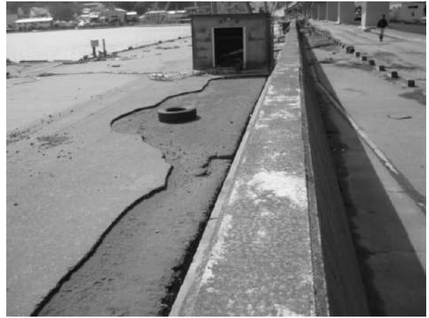
写真-6.2.2.19 防潮堤（須賀地区）の状況
