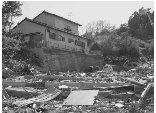
図-5.4.1.12 釣師浜漁港奥の被災状況（その2）
