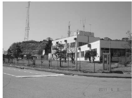
写真-5.5.2.1 日立埠頭県営3号上屋付近(電話ボックス)
