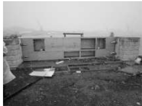
写真-6.3.27 仙台塩釜港（塩釜港区）観光棧橋の陸閘
