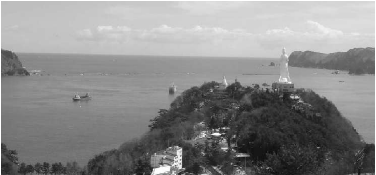
写真-6.2.2.15 釜石港湾口防波堤の全景（被災後）
