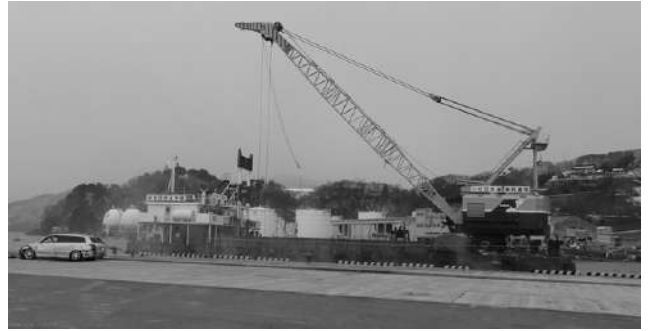
写真-5.2.3.14 航路・泊地啓開作業中の起重機船 (3月17日)
