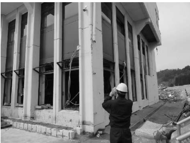
写真-5.2.5.3 第二防潮堤の背後の建物
