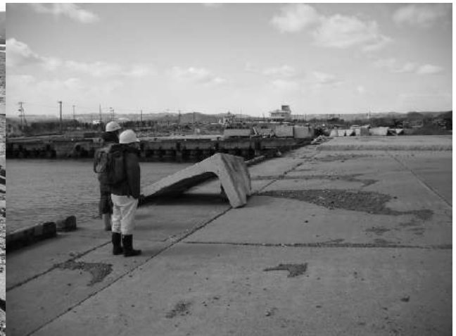
写真-6.2.1.8 諏訪下地区岸壁 (-10m) —大型の漂流物の一例— (平成23年3月18日撮影)
