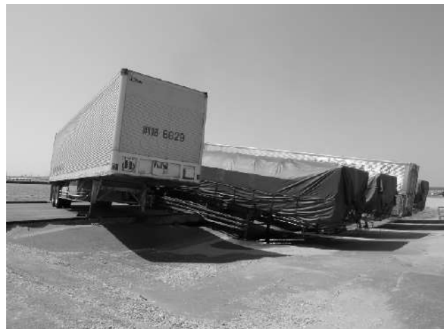
写真-6.5.1.3 第4埠頭重力式岸壁(-12m)背後 (2011年4月14日撮影)
