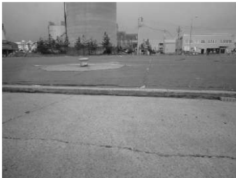
写真-6.3.12 中野埠頭 2号~4号岸壁のエプロン部と荷捌ヤードの境界付近 (写真番号⑤)
