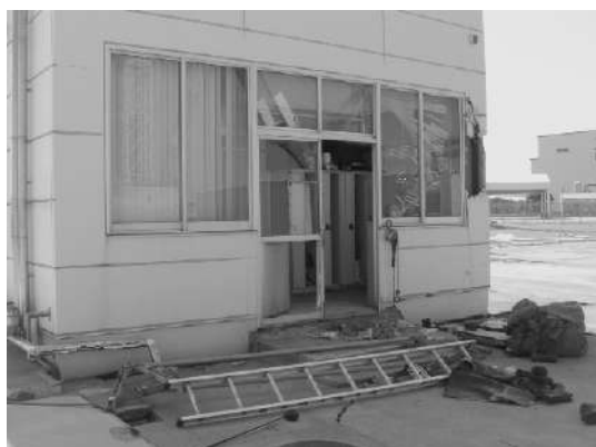
写真-5.5.2.7 日立港区第四埠頭地区 日立埠頭コンテナターミナル事務所
