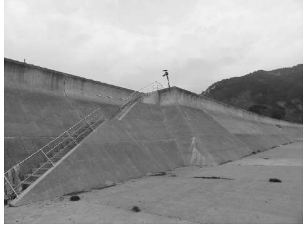
写真-5.2.5.9 防潮堤の様子
