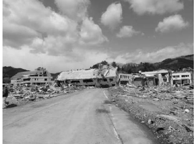
写真-5.3.4.5 岸壁近くにあったと思われる3階建のアパートが流され様子と右隣は2階建の交番の横倒し （2011年3月27日に撮影）
