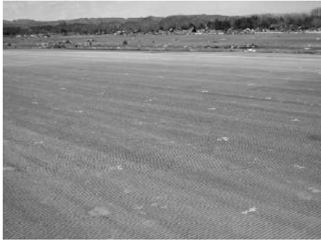
写真-6.3.25 仙台空港 B 滑走路摺付け改良部の状況 (写真番号④)
