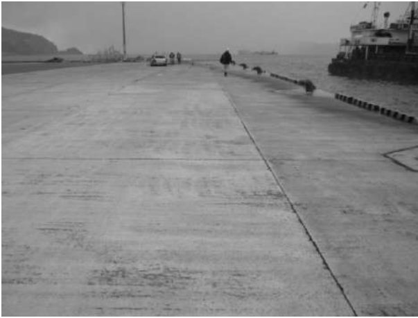
写真-6.2.2.9 エプロンの状況（異状なし）
