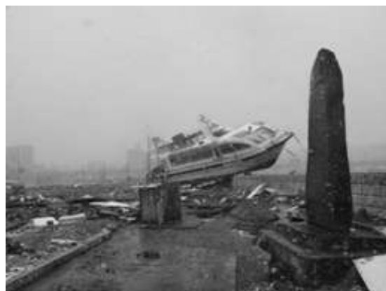
写真-5.3.6.1 西埠頭観光栈橋周辺の様子 （2011年3月17日撮影）
