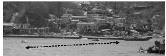
図-5.2.1.13 玉の脇防波堤の被災状況
