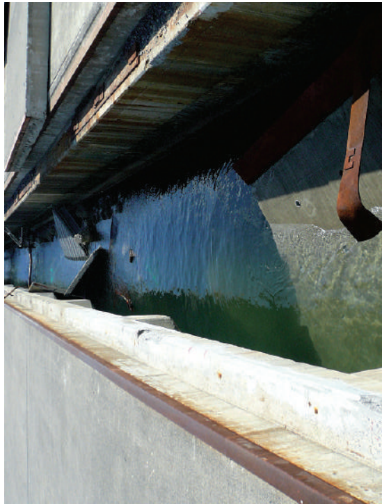
写真-6.2.1.11 諏訪下地区棧橋（-7.5m）一津波による渡版の被害― （久慈港諏訪下地区）（平成23年3月18日撮影）
