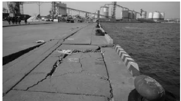
図-6.4.2.3 構造変化位置での法線の出入り
