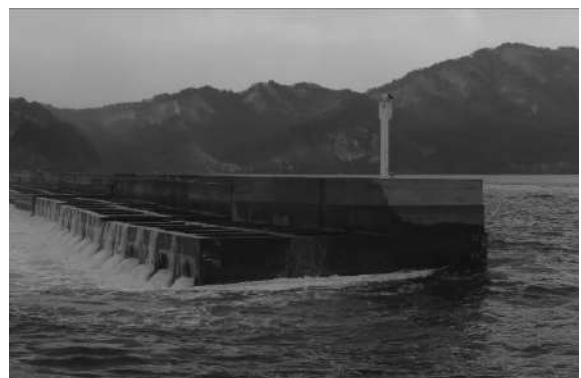
写真-7.1.4 残存している南堤(堤頭部港内側から)
