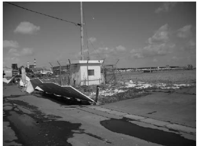
写真-2.2.2.2 八戸港の強震観測小屋 —地震後に津波を受けた様子— （平成23年3月17日撮影）
