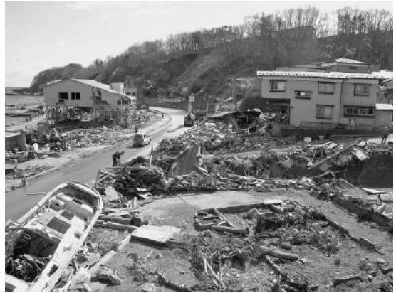
図-5.2.1.6 玉の地区の被災状況
