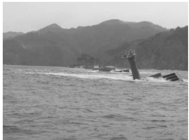
写真-6.2.2.17 北堤の状況
