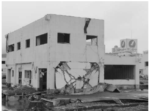
写真-5.3.3.2 2階建ての建物の壁面破壊
