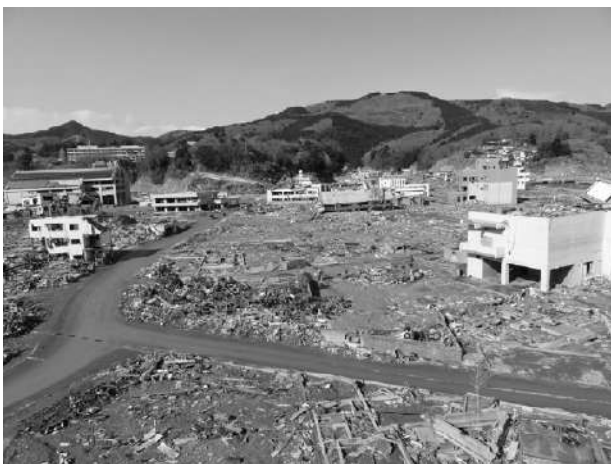
写真-5.3.4.4 女川病院から見た被害の様子① （2011年4月9日に撮影）
