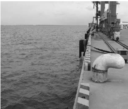
写真-6.1.1.5 八太郎地区J岸壁の法線の状況 (平成23年3月17日撮影)
