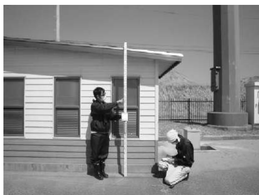
写真-5.5.3.3 ケーソンヤード(公衆トイレ)の泥水痕跡
