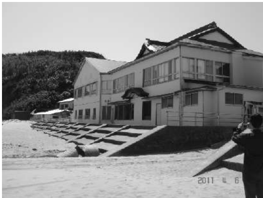
写真-5.5.3.8 阿字ヶ浦海岸背後の旅館
