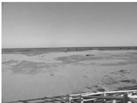
写真-5.3.8.10 離岸堤（2011年3月18日撮影）
