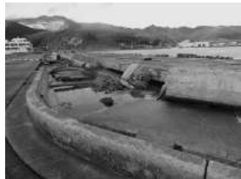
写真-6.3.28 女川漁港の岸壁直背後の様子
