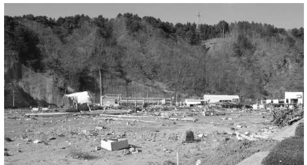
図-5.2.1.9 半崎地区・国家石油備蓄基地の地上施設の被災
