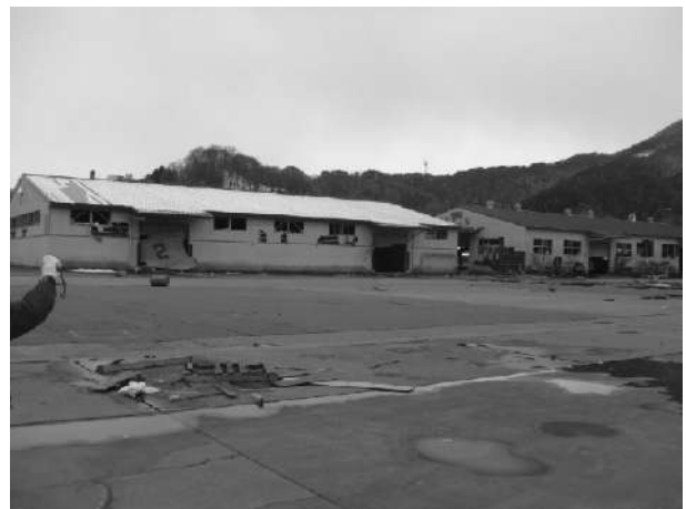
写真-6.2.2.14 県営上屋の状況
