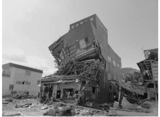
写真-5.3.2.6 漂流した船の通った道沿いにあった鉄骨3階建ての建物 (2011年3月28日撮影)
