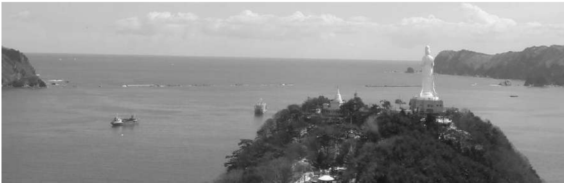
写真-7.1.2 被災後の防波堤(全景)
