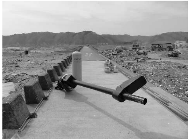
写真-5.2.5.4 防潮堤より（右側が山側、左側が海側）
