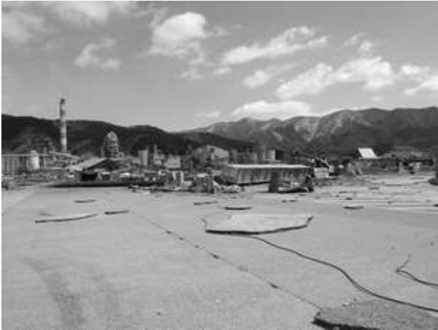
写真-5.2.4.5 防潮堤のゲートの流出 (3月18日)
