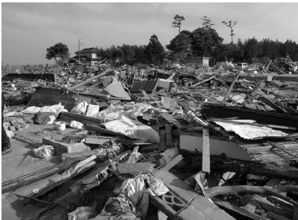
図-5.4.2.8 兎渡路の被害状況
