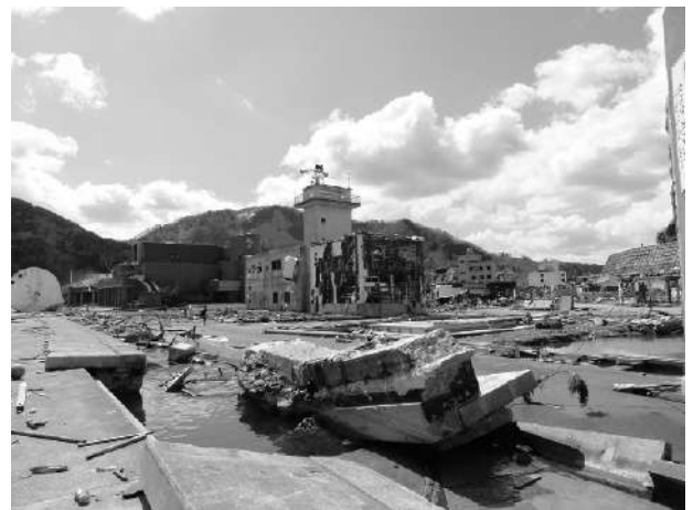
写真-5.3.4.3 岸壁の天板の破壊
