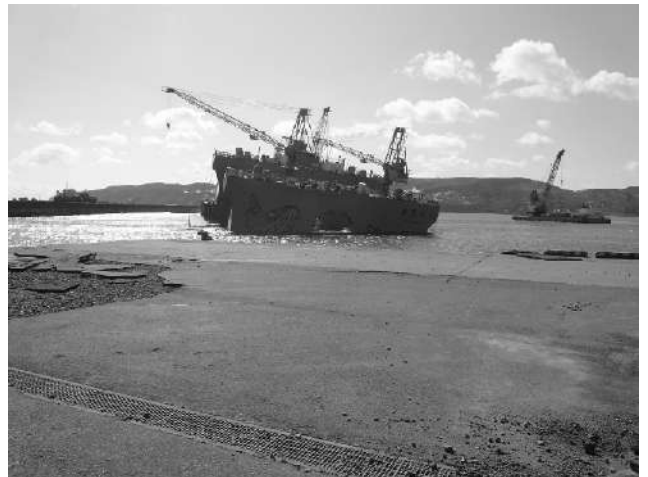
写真-6.2.1.6 諏訪下地区岸壁 (-10m) —流出したフローティングドック— (平成23年3月18日撮影)
