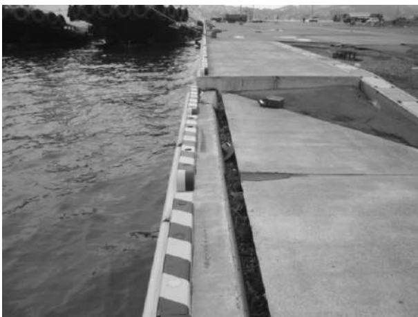
写真-6.2.2.5 湾奥側取付部との境界付近
