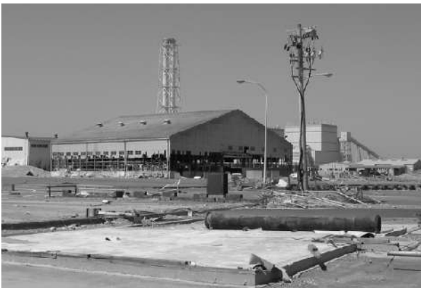
図-5.4.1.6 第1埠頭奥の上屋の被災状況
