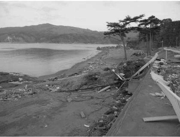
図-5.2.2.16 高浜地区における海岸の状況
