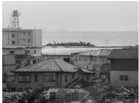
写真-5.3.5.4 離岸堤（2011年3月16日撮影）
