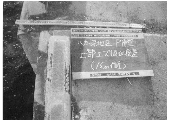
写真-6.1.1.1 八太郎地区 P 岸壁の法線の出入り (八戸港湾・空港整備事務所，2004)（平成15年度撮影）
