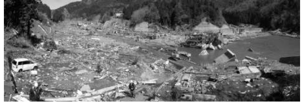
写真-5.2.3.19 両石地区の被災状況
