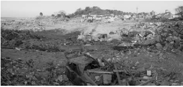
図-5.4.1.10 原釜尾浜海岸奥の被災状況
