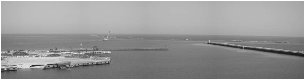
図-5.4.1.13 沖防波堤の被災状況
