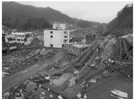
写真-5.3.4.10 女川病院から見た被害の様子③(3) (2011年4月9日撮影)
