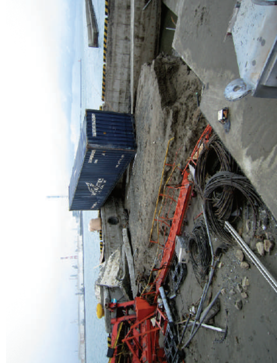
写真-6.2.1.11 諏訪下地区棧橋（-7.5m）一津波による渡版の被害― （久慈港諏訪下地区）（平成23年3月18日撮影）
