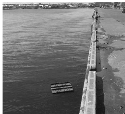
写真-6.1.1.3 八太郎地区 P 岸壁の地震後の法線の状況 (平成23年3月17日撮影)
