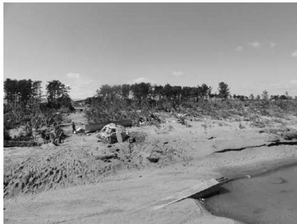
写真-5.3.8.5 砂浜背後の松林と砂丘および洗掘孔（図中右）（2011年3月18日撮影）
