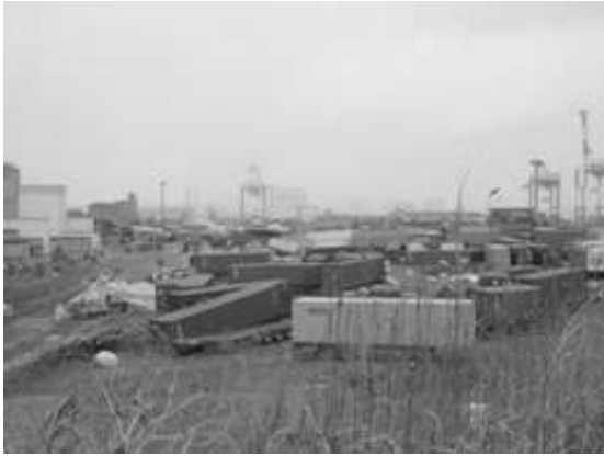
写真-5.3.7.3 高砂埠頭におけるコンテナ散乱の様子 (2011年3月17日撮影)
