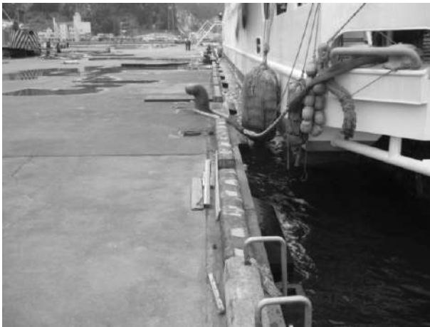
写真-6.2.2.11 岸壁法線の状況 (異常なし)
