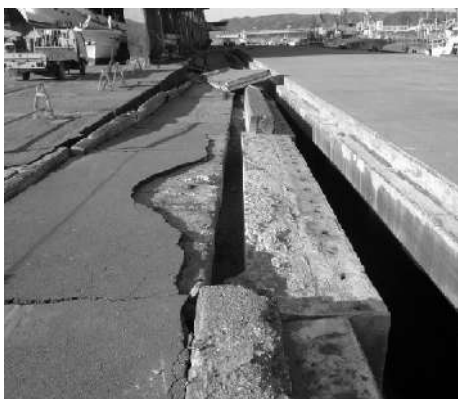
写真-6.2.1.17 諏訪下地区栈橋 (-6.0m) —栈橋背後の土留めの前出し— (平成 23 年 3 月 18 日撮影)
