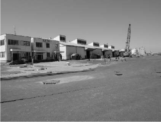
写真-5.5.5.4 鹿島港(南公共埠頭)
