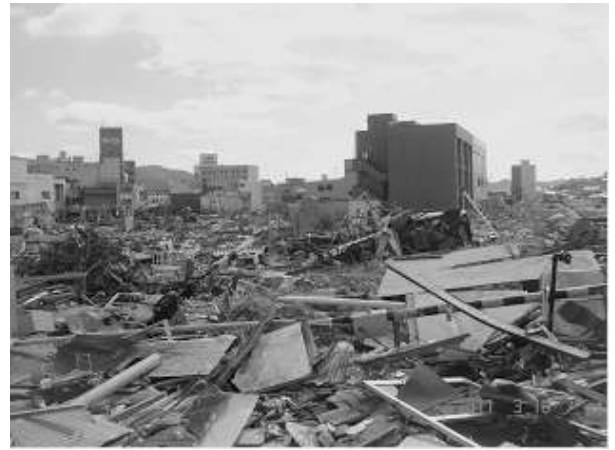
写真-5.2.4.8 大船渡駅周辺の被害 (駅北の踏切から)
