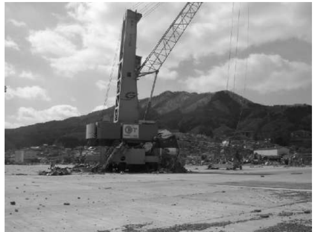
写真-6.2.3.8 ハーバークレーンの状況
