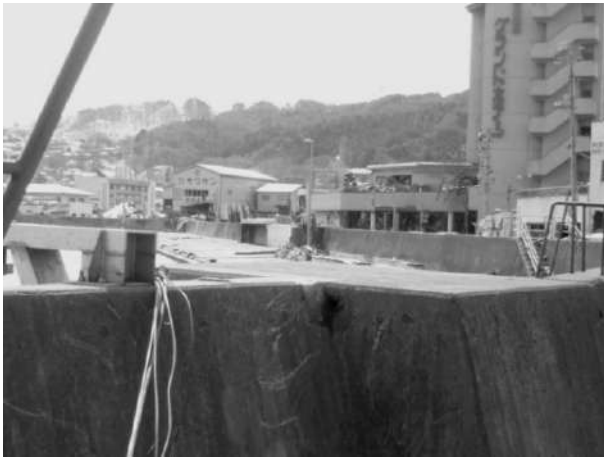
写真-6.2.2.18 防潮堤（須賀地区）の状況
