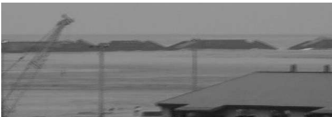
写真-7.1.1(3) 被災の進行状況(3)
