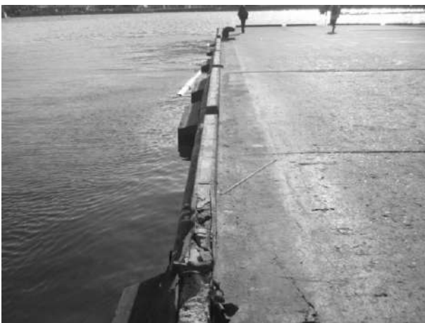
写真-6.2.3.11 栈橋法線の状況 (異状なし)
