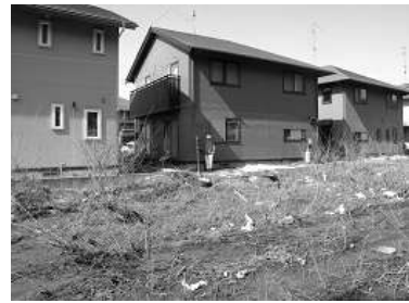
図-5.1.1.5 階上町大蛇地区の津波痕跡
