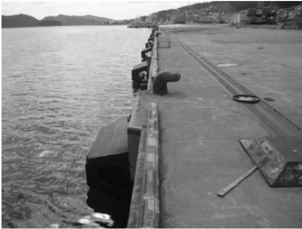
写真-6.2.3.5 栈橋法線の状況（異状なし）
