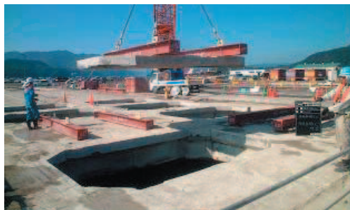
写真-1 RC部材の撤去（部材No.Ma-1）
