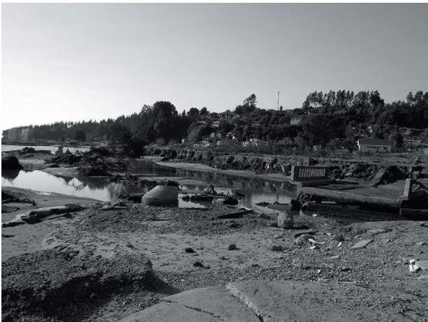
写真-4.9 デイチャットにおけるデイチャット川河口部の洗掘
