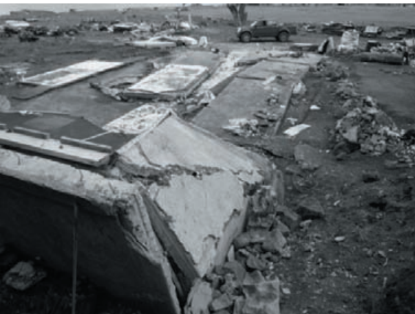
写真-4.18 鉄筋コンクリート造りの教会を背後（斜面側）から撮影
