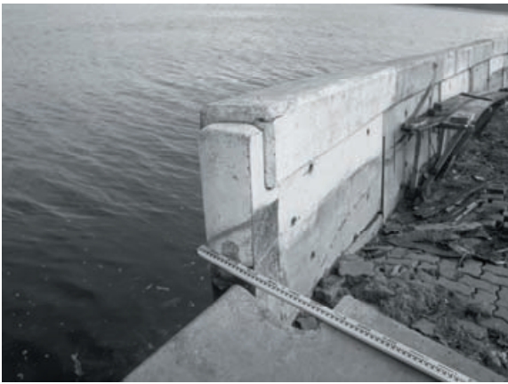
写真-4.23 鉄筋コンクリート造りの護岸の張り出し (L9)
