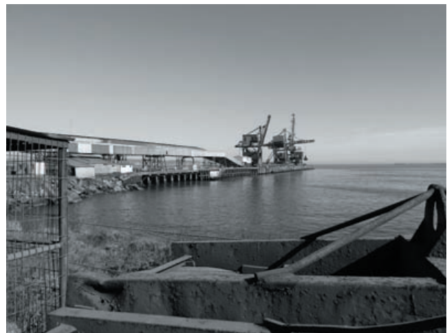
写真-5.4 ワチパト製鉄会社専用縦棧橋の被災状況
