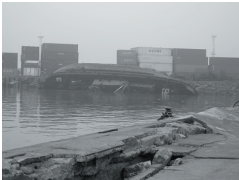
(a)岸壁に係留された船舶の被害
