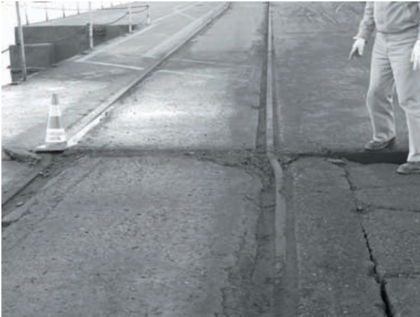
写真-5.5 ワチパト製鉄会社専用縦棧橋 護岸部(手前)と棧橋(奥)の境界部におけるクレーンレールの曲り
