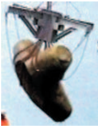
写真-5.3 実際の破損ブロックの吊り上げ
