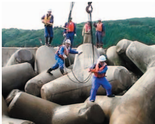
写真-1.1 作業員によるブロックへの玉掛け作業
