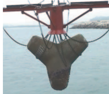
写真-5.2 実際のブロックの吊り上げ状況(ケース 3)
