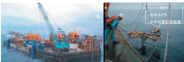
写真-4.3 作業台船 写真-4.4 ROV 搭載吊り枠
