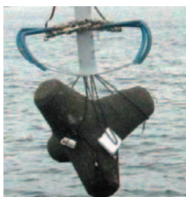
写真-3.3 ブロックの吊り上げ
