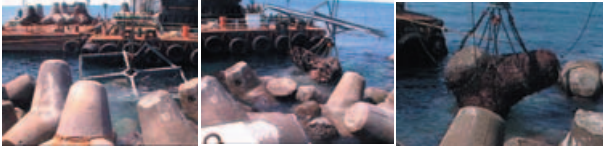
写真-3.16 破損ブロックの吊り上げ
