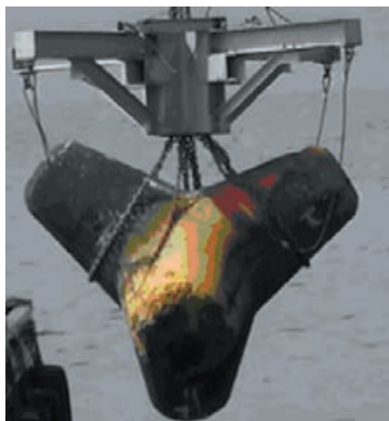
写真-3.18 支持枠小型化
