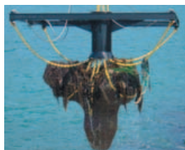
写真-3.8 吊り上げ完了
