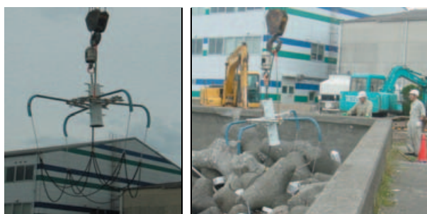
写真-3.1 網チェーン把持装置 写真-3.2 ブロック把持
