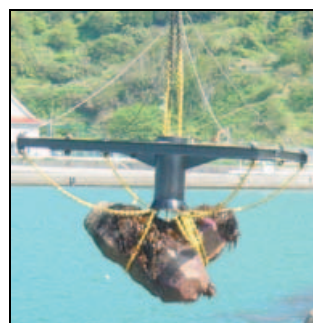
写真-3.9 破損ブロックの回収
