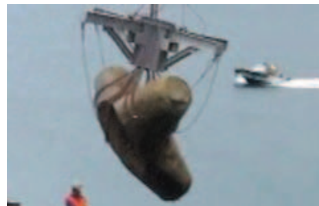
写真-3.19 破損ブロックの回収
