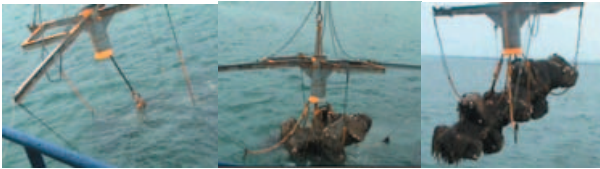
写真-3.12 水面下の視認不可ブロックの回収
