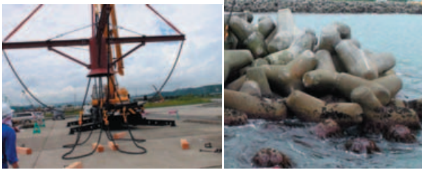
写真-3.20 網チェーン把持装置 写真-3.21 撤去場所
