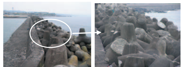
写真-3.15 ブロック撤去場所
