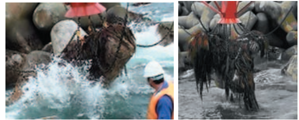
写真-3.22 荒天での作業 写真-3.23 海藻付着ブロック
