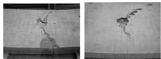
写真-4.2 試験体上面の破壊状況 (35回衝突後) a) C-1試験体 b) A-2試験体
