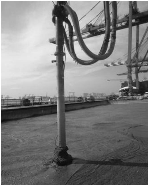
図-5.1.1 軽量混合処理土のトレミー打設状況
