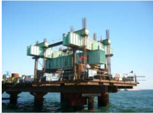
図-5.6 押し込み試験装置
