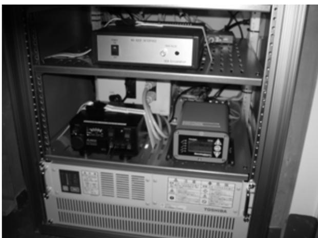
図-6 無停電電源装置，サテライトコンパス，ADCP，水質測定装置の各種変換器
