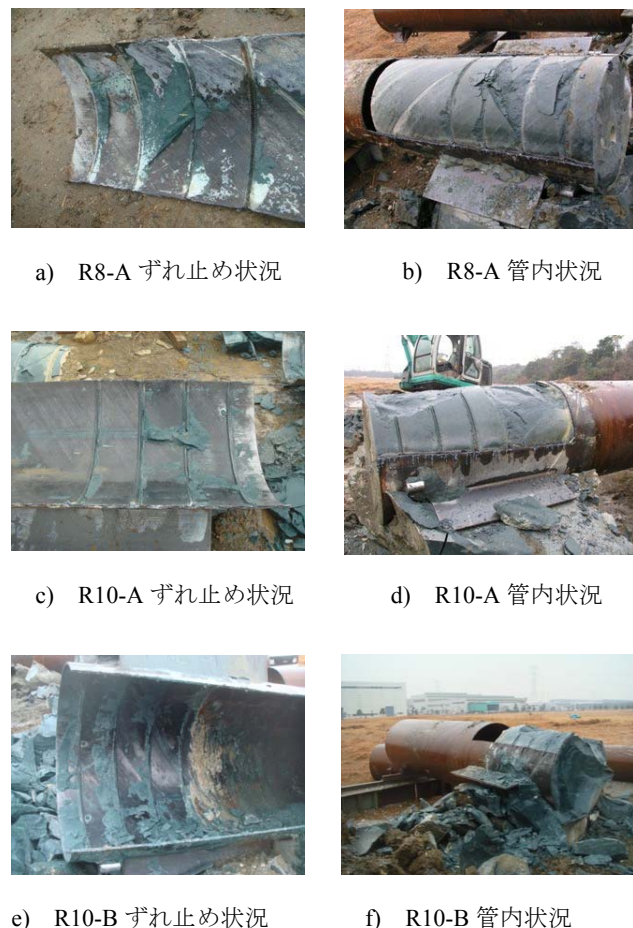
図-5.32 根固め部解体状況
