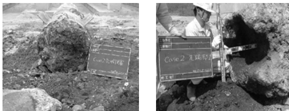
A 先端部断面 B 先端部形状 a) No.2 根固め部形状
