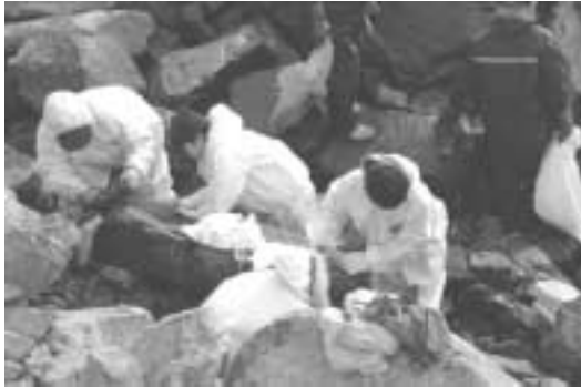
写真—26 岩場の洗浄作業 (PARI 撮影)
