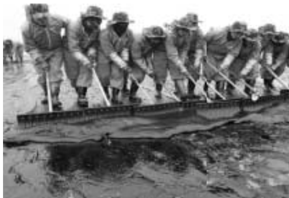
写真—19 レーキによる油のかきよせ 17)
