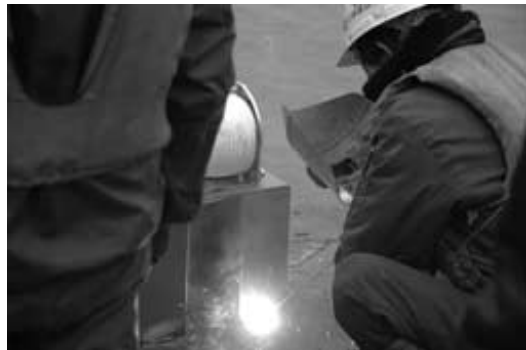
写真-33 ウインチ（自動展張ブイを繋ぐ）の 甲板上固定作業
