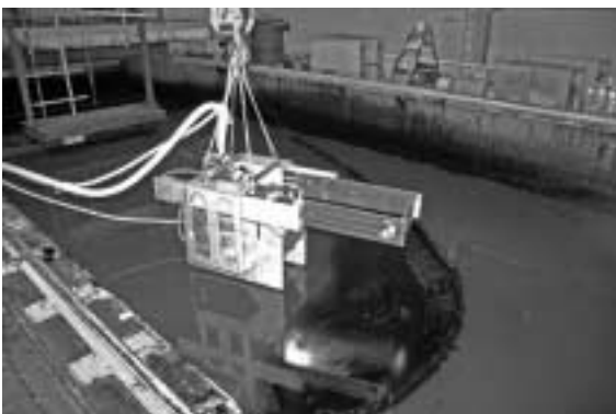
写真-10 かき寄せバケット式スキマーの投入
