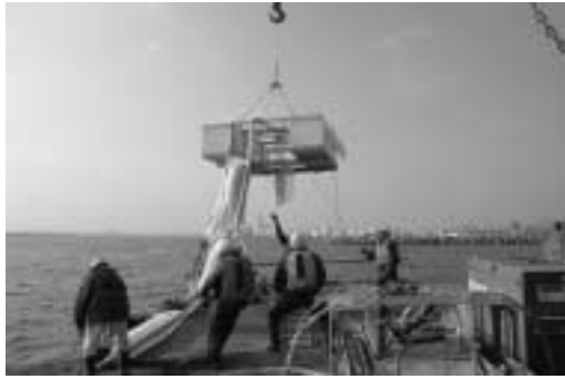
写真-40 自動展張式オイルブームの撤収
