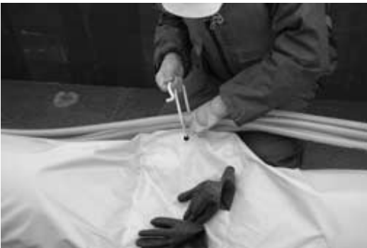
写真-29 ジェット水用ホースの オイルブームへの取り付け
