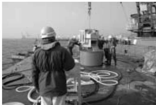
写真-39 海水をかきとって貯油タンクへ排出。 手前が制御盤とオペレータ
