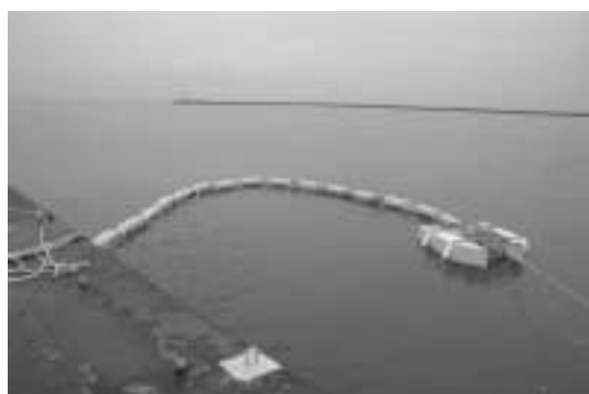
写真-35 自動展張式オイルブームの展張
