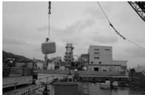
写真-26 トラックから台船上への積み込み作業
