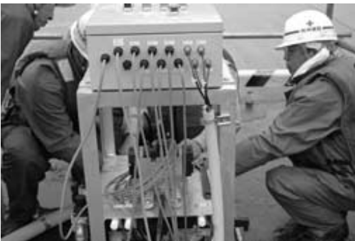
写真-30 油回収機制御盤の結線作業等
