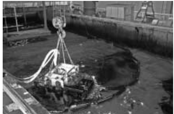
写真-11 油回収作業 (かき寄せレーキでかきよせ、上蓋が開いて油水を取込む)
