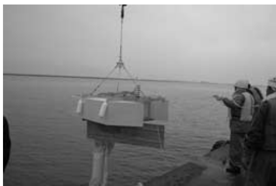
写真-34 自動展張式オイルブームの設置
